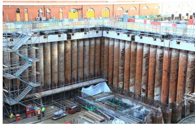
写真② 鋼管矢板施工後の掘削状況
