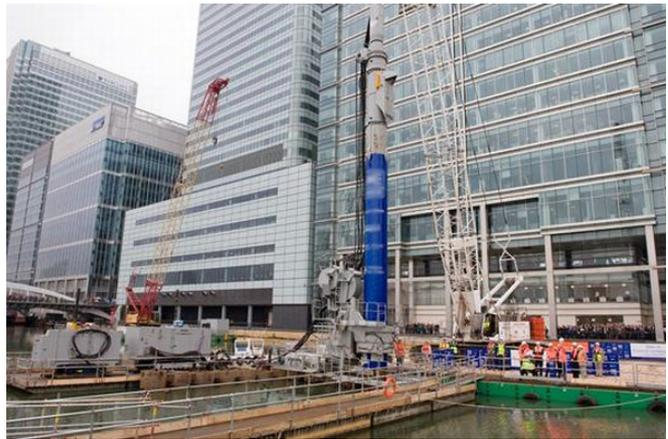
写真① 駅舎本体の構築に用いた鋼管矢板による締切り
