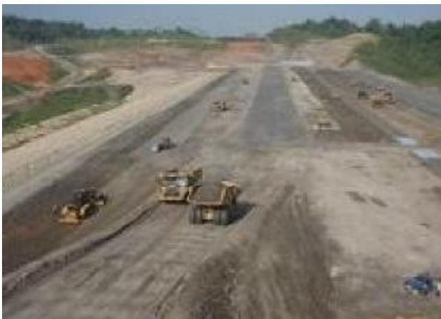
湖山ダム盛り立て状況全景
