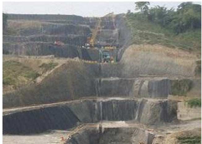
副ダム左岸連壁施工状況
