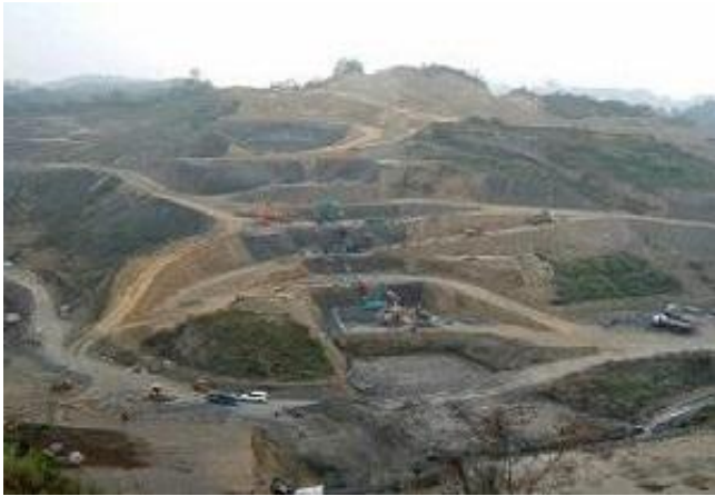
主ダム左岸連壁施工状況
