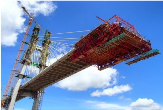
写真-3 張出し施工状況
