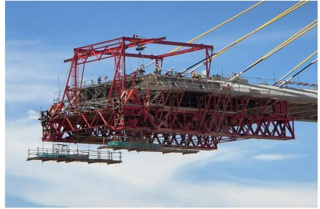
写真-4 下支え式移動作業車
