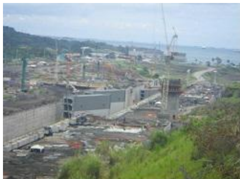
大西洋側新ガトゥン閘門建設工事の様子
