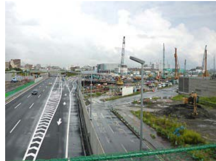
【京葉ジャンクション】 重機の並ぶ工事現場を望む
