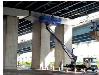
【東関東道浜町南高架橋】 点検現場の高架下
