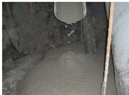
写真-10 打設地点コンクリート状況
