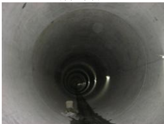
写真-3 導水路トンネル
