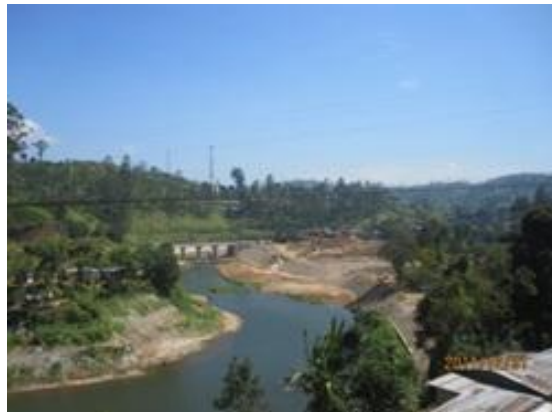
写真-2 湛水池護岸
