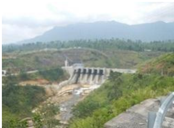
写真-1 取水ダム
