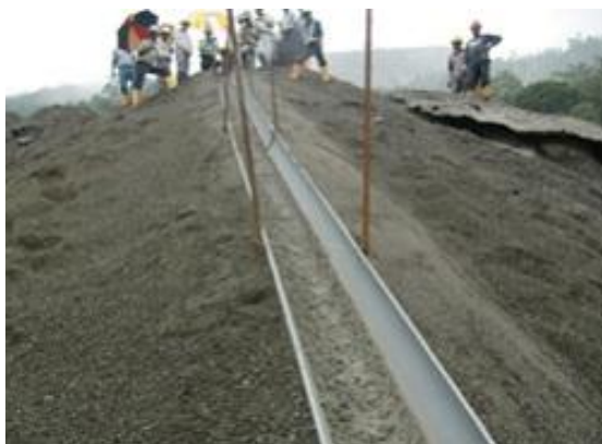
写真-9 長距離シュート打設試験施工
