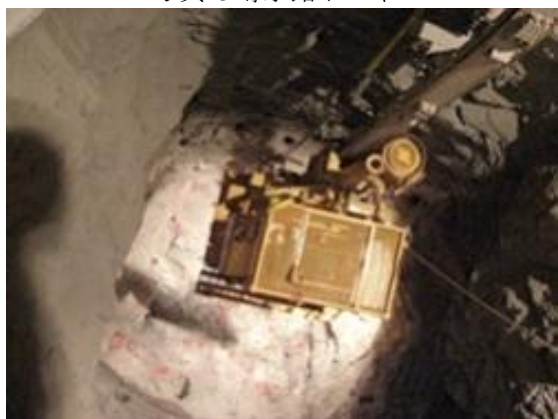
写真-5 鉄管水路（先進導坑掘削）
