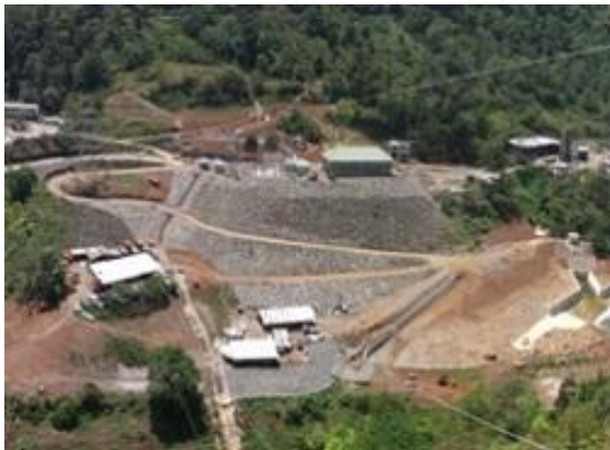
写真-7 開閉所全景
