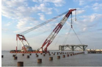
ジャケット施工の様子(ティラワ港)
