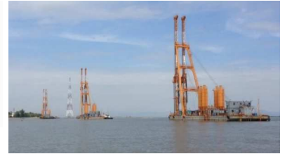
CDM施工の様子(ラックフェン港)
