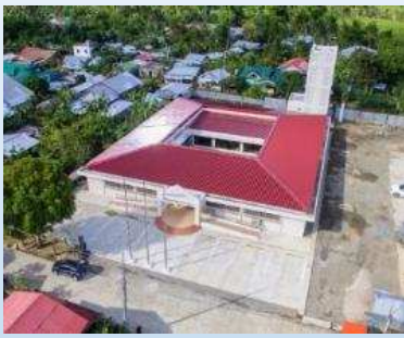
ラワン市行政庁舎 平屋建て 840㎡ 出典：「台風ヨランダ災害復旧・復興計画」完了届
