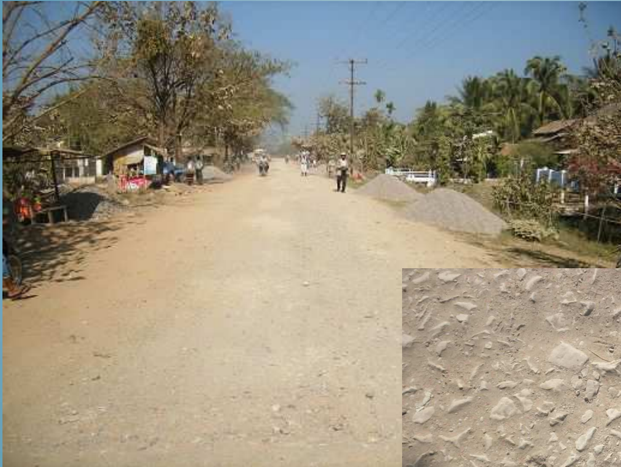
着工前道路狀況
