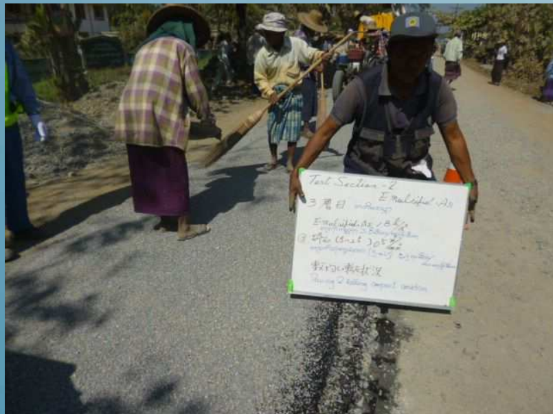
碎石の人力撒布 調整
