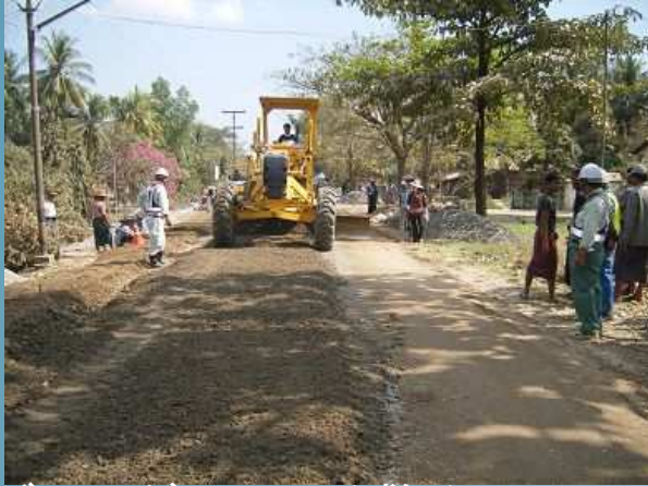
グレーダーによる敷均し
