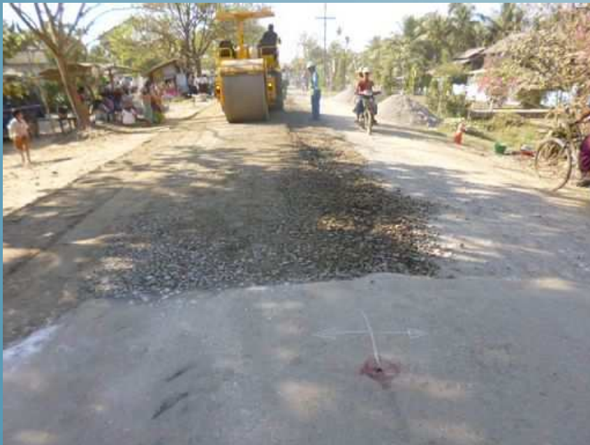
マカダムローラーによる転圧
