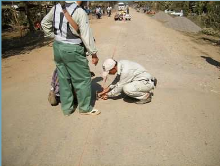
センター鋏・設置
