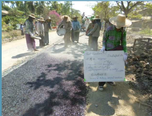
碎石の人力撒布 調整
