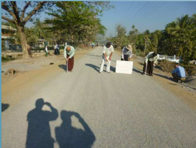
仕上がり高さの確認
