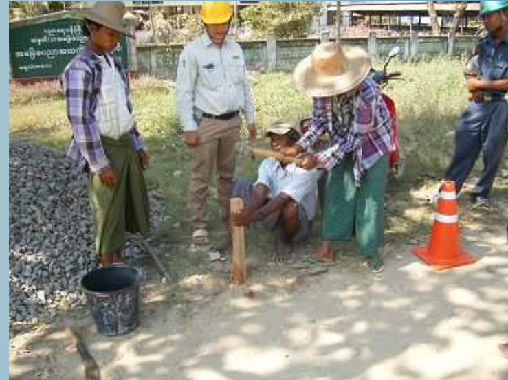
路肩丁張設置(φ~4m)
