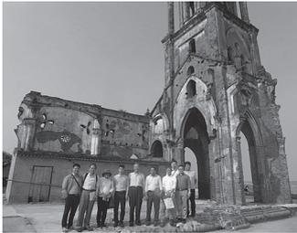
海岸浸食と台風被害により崩壊した Hay li 地区の教会
