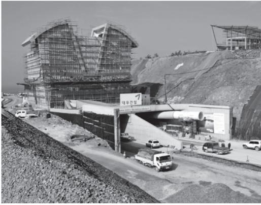
写真3 釜山巨済島連絡道 沈埋トンネル入り口の施工状況
