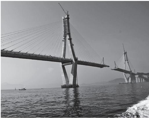
写真4 斜張橋の施工状況
