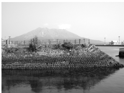
鹿児島旧港施設
