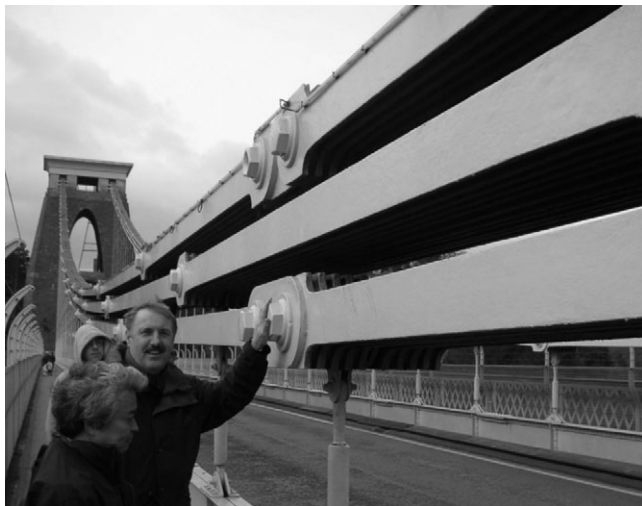
写真-5 クリフトン橋のチェーン
