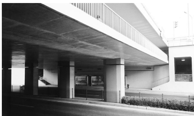
写真-2 北京市内の歩道・自転車道が桁の中にくみこまれた立体交差
