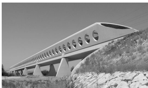
写真 エプロ川に架かる新幹線鉄道橋
