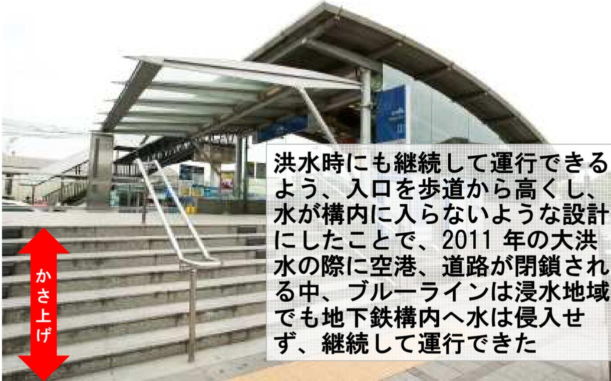
洪水時にも継続して運行できるよう、入口を歩道から高くし、水が構内に入らないような設計にしたことで、2011年の大洪水の際に空港、道路が閉鎖される中、ブルーラインは浸水地域でも地下鉄構内へ水は侵入せず、継続して運行できた
