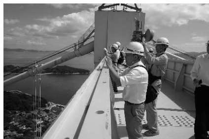
写真17 瀬戸大橋塔頂の様子
