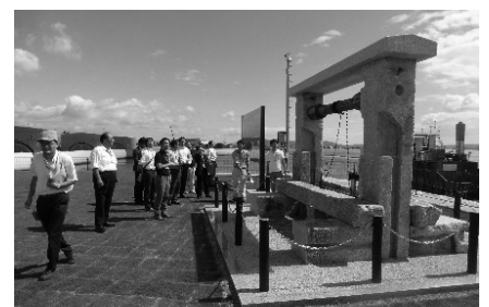
写真21 百間川河口水門
