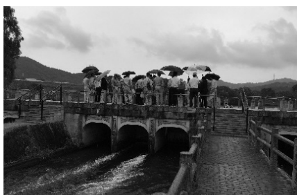
写真19 酒津公園樋門
