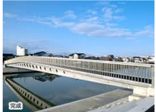
「ダクトル」を用いた酒田みらい橋(山形県)
