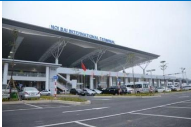
ノイバイ国際空港 第二ターミナル (2015年完成)
