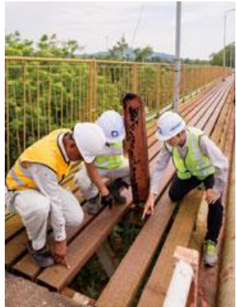
橋の架け替えまでの間、日本の専門家がサポート(アトラン橋)
