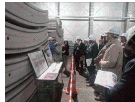
八王子南バイパス工事現場での説明の様子
