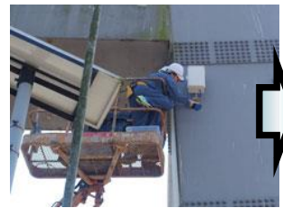
傾斜計によるタワーの傾斜モニタリング(トンテイ橋)
