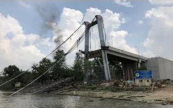
崩落したミャウンミャ橋 出典：東京大学生産技術研究所
