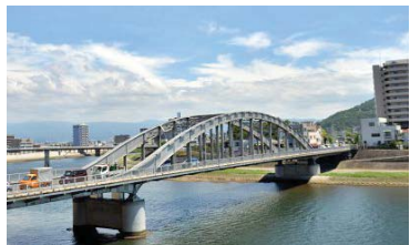
静岡県沼津市 御成橋
