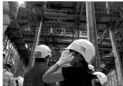
地下33mの軌道場を見学
