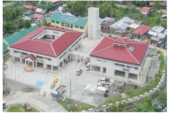
写真1 再建した行政庁舎・地域保健施設
