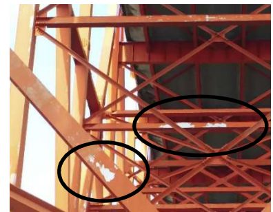
写真 3 塗膜の劣化状況 (丸囲い箇所)
