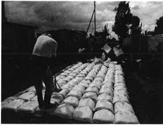
図-1 土のうを利用した未舗装道路整備状況
