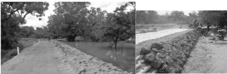
Construction de mur latéral
