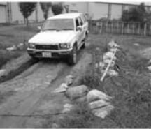
道路面の沈下量
