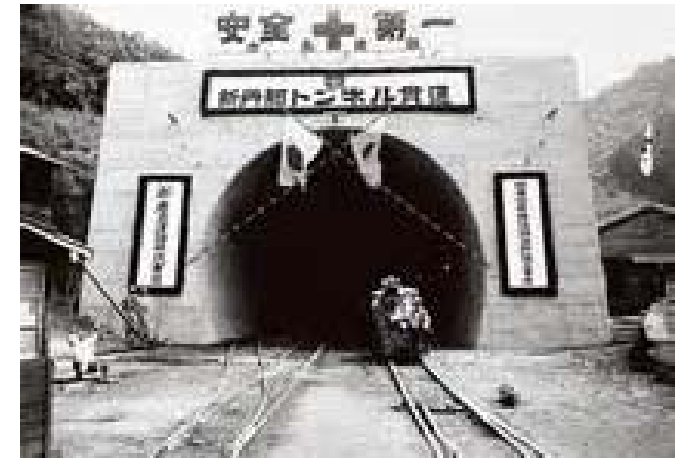
トンネルの貫通
