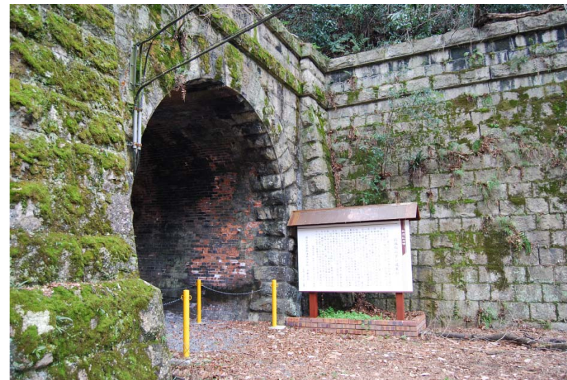
東海道本線 旧逢坂山トンネル
