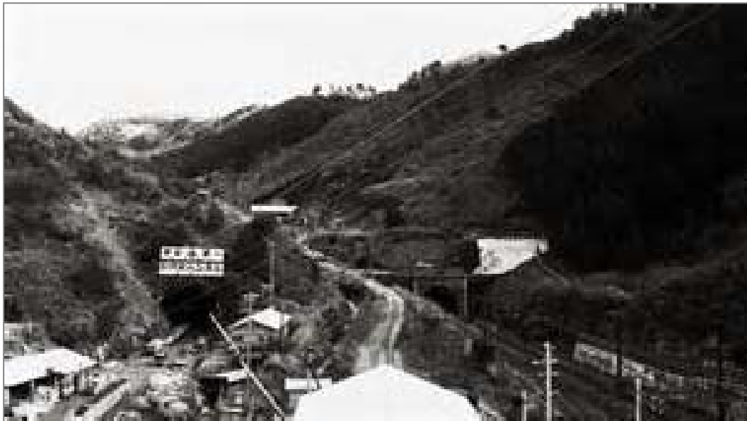
着工当初の新丹那トンネル函南口付近(左)
