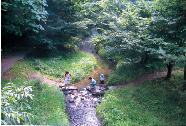
精進川 札幌市 ふるさとの川づくり 既存のコンクリート積み護岸を破壊 都市内の河川を近自然型工法で緻密に再生
