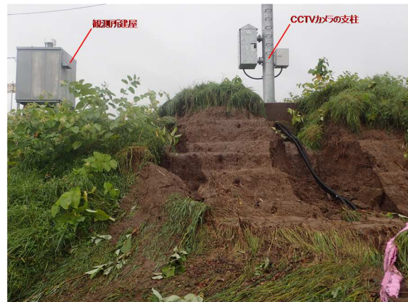
図1 越流浸食による被害状況
