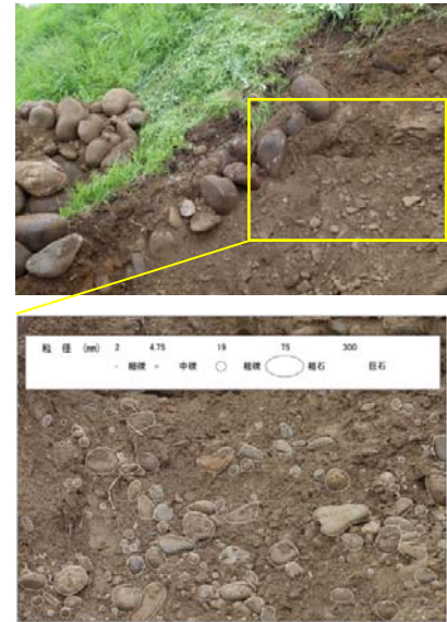
写真3 石混じり礫質盛土の状況
