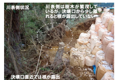
写真-1 川表側の樹木根の状況
