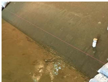
写真2 模型2の変状開始時
