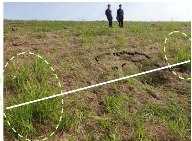
写真-3 陥没箇所を通る縦断測線 C 上の植生状況
