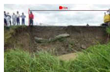
写真 1 上流側被災箇所
