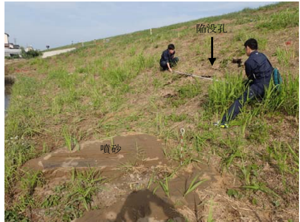
写真-2 左岸 3.8k 付近の噴砂と法面陥没
