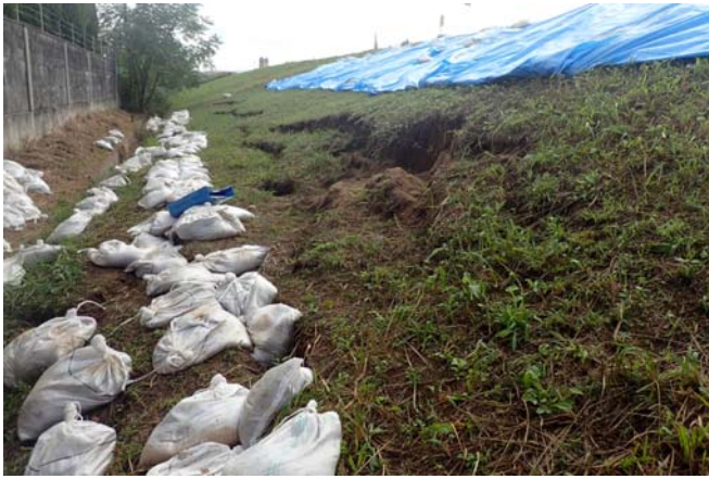
写真-1 右岸 2.4k 付近の裏法面滑り
