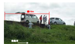
写真 2 下流側被災箇所
