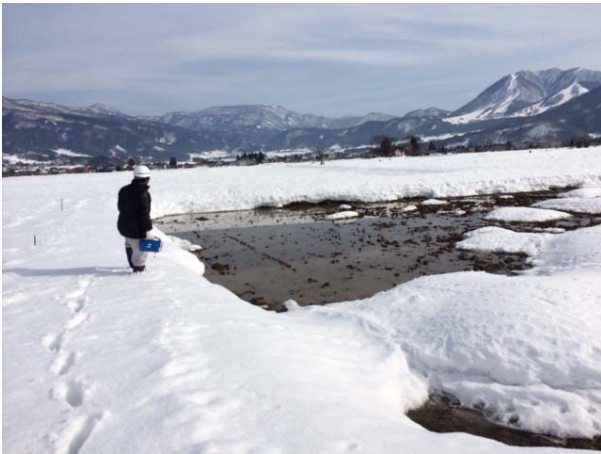
写真-1 2013年9月右岸31.5k付近の漏水発生箇所の融雪期の湧水状況(2014年3月調査時)
