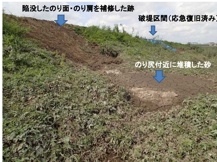
河川水により堤体でパイピングが生じ、破堤したと考えられる。
