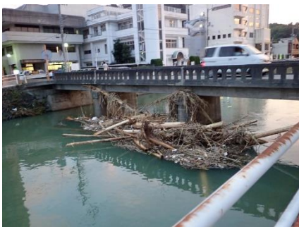
写真 2-6-5 ⑤はまだ橋の流木
