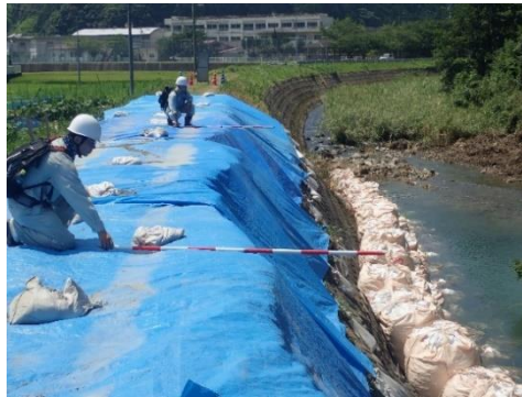
写真 2-5-1 ①中央橋下流右岸側
