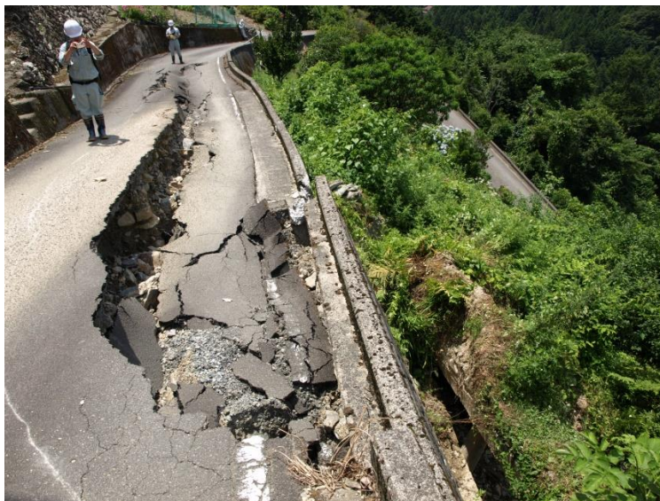
写真 3-7-2 山城町光兼：集落内の道路を寸断した小崩壊（2018年7月13日撮影）
