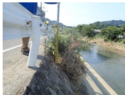
写真 2-6-10 ⑭路面より下の痕跡
