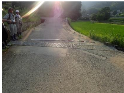
写真 2-9-11 ⑦鏡川橋右岸上流浸水
