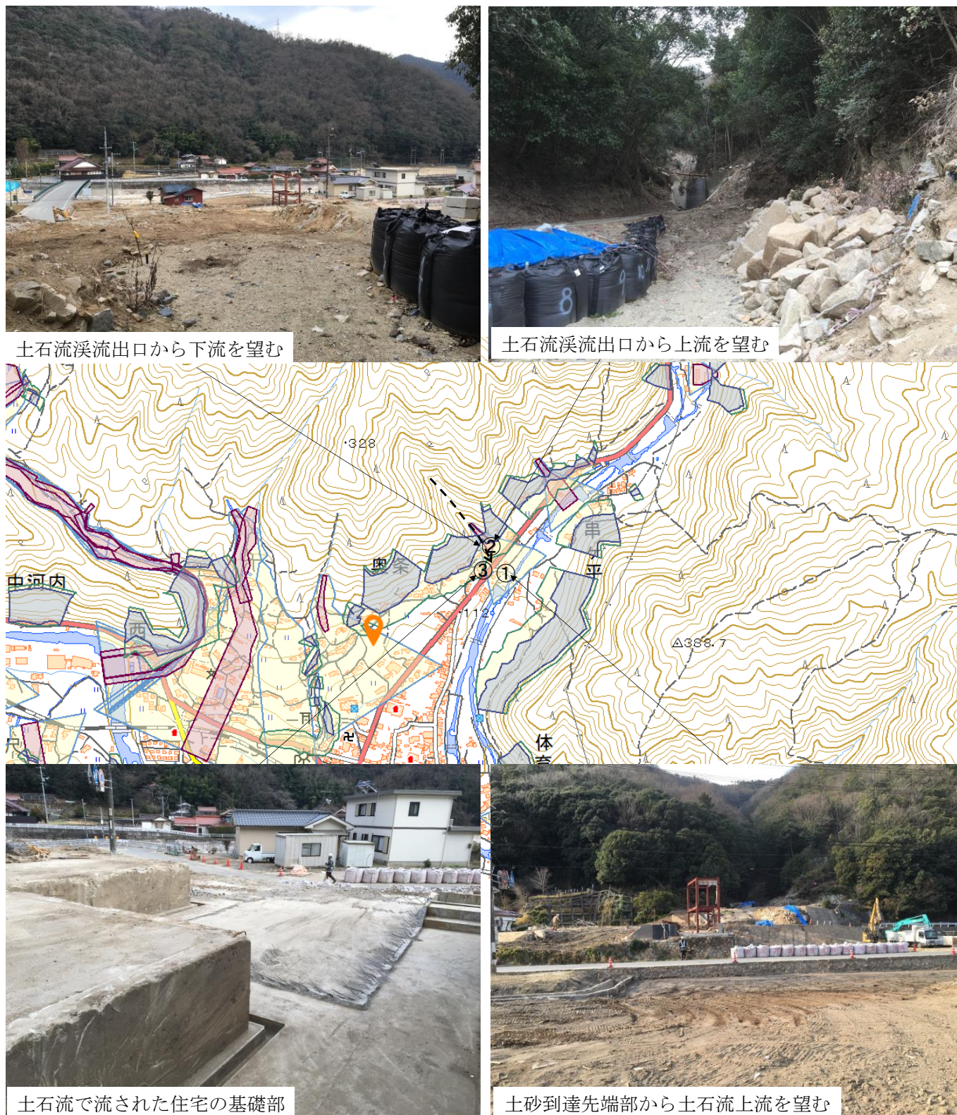
図3-6-24 東広島市河内町中河内の被害 (広島県防災Web 3) より加筆)
