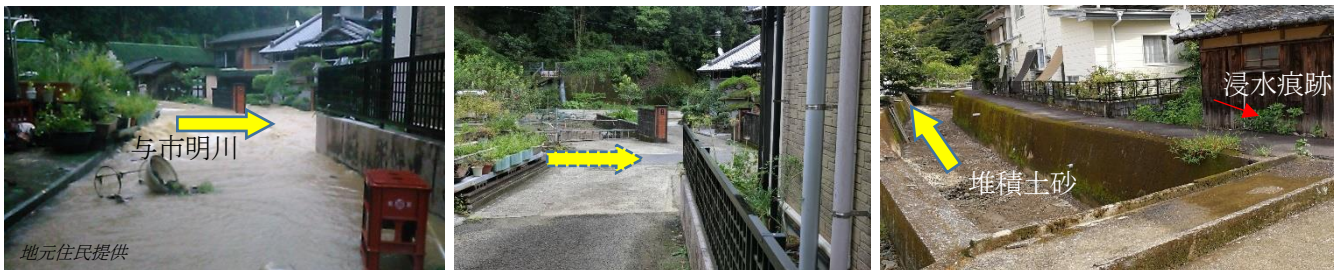
写真 4-2-4 与市明川上流における氾濫（左：浸水時，中：平常時，右：浸水痕跡）
