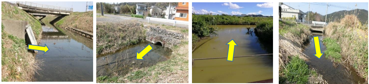
写真 4-2-5 与市明川への排水状況
