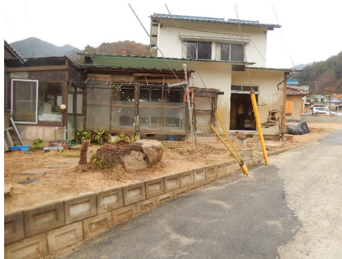
(b) 上流向け(右岸の被害)
