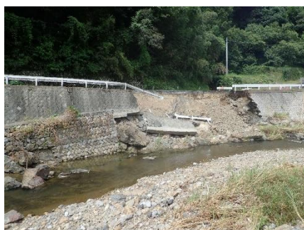
写真 2-7-6 ⑦湾曲部外側の護岸崩壊
