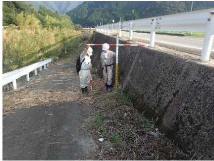
写真 2-9-9 ⑤新鏡川橋下流右岸
