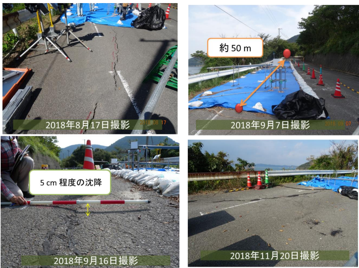
図 5.3.5 県道高松王越坂出線の王越町から高松方面における現地調査結果
