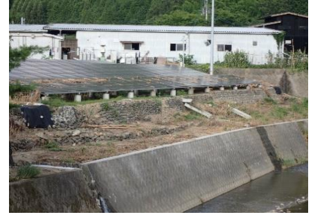
写真 2-9-6 ②鏡川橋下流左岸側
