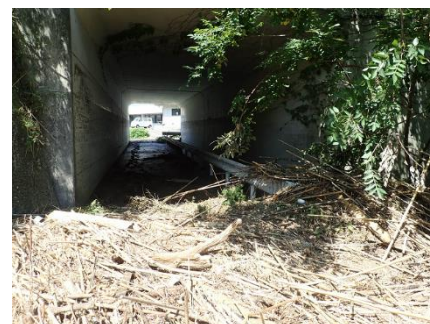
写真 2-8-8 ④ボックスカルバート
