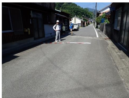
写真 2-8-7 ③水際線(奥が浸水)
