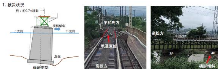
図 5.2.7 財田川橋梁の被災状況(提供：JR 四国)
