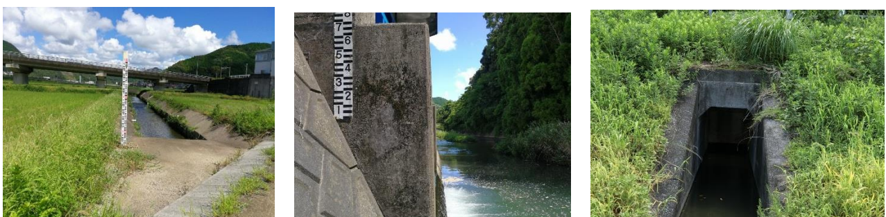
写真 4-2-3 和田地区の排水路（左）、水門（中）とフラップゲート（右）
