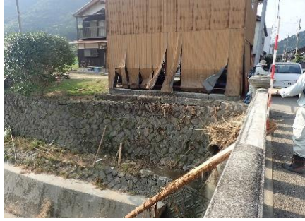
写真 2-9-5 ①鏡川橋上流左岸側
