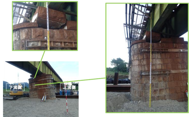
d) 損傷した4P 橋脚
