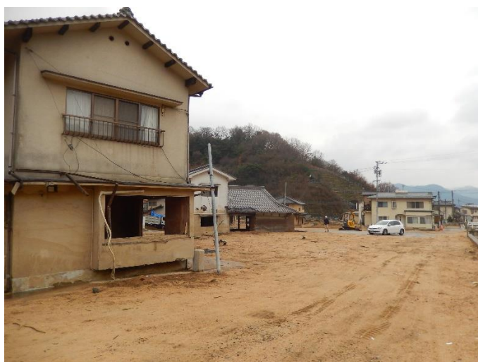
(a) 下流向け(左岸の住宅被害)
