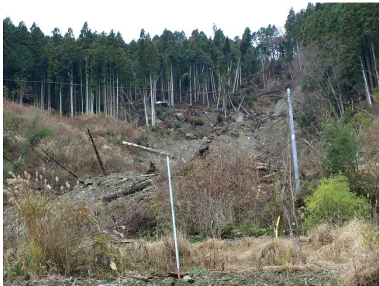
写真 3-7-3 山城町仏子：集落内の道路を寸断したやや深い崩壊（2018年12月12日撮影）
