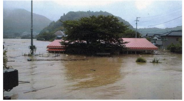
写真3-2-1 肱南保育所の浸水状況（大洲市提供）
