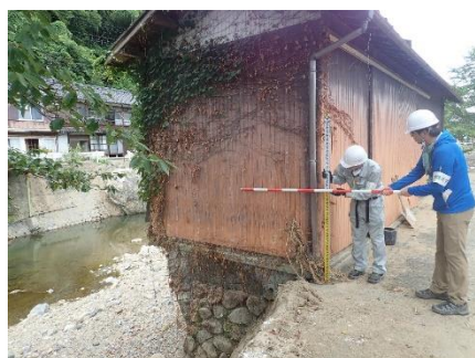
写真 2-7-1 ②中川原橋右岸上流
