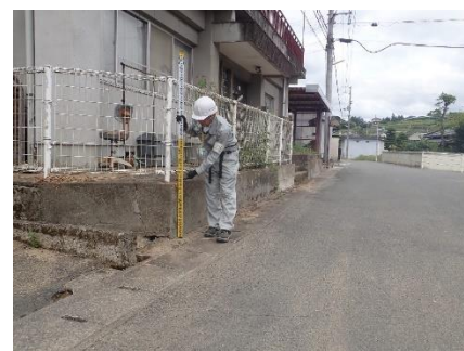
写真 2-7-3 中川原橋左岸上流
