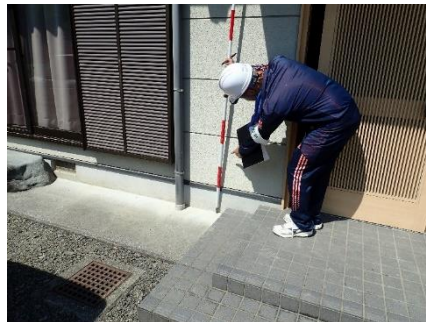
写真 2-8-1 ①豊盛集会所浸水痕跡
