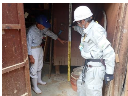
写真 2-7-4 ⑤弁天橋付近の民家
