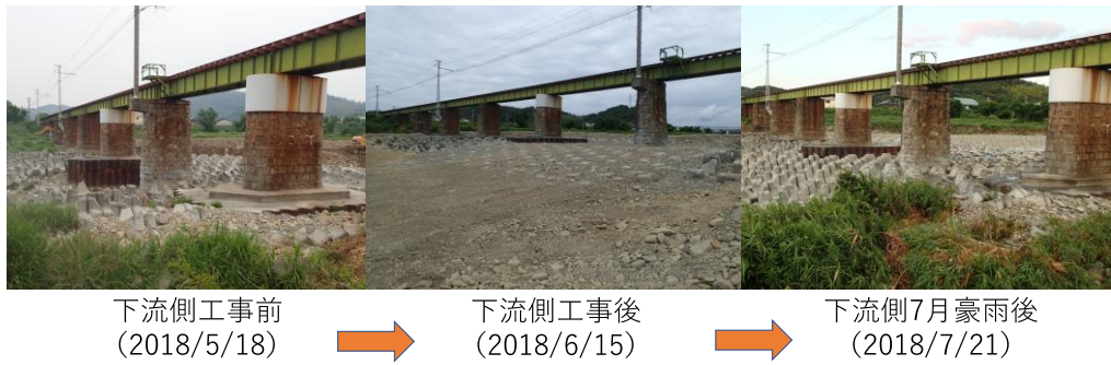
図 5. 2. 4 土器川における橋梁周辺の河床変化
