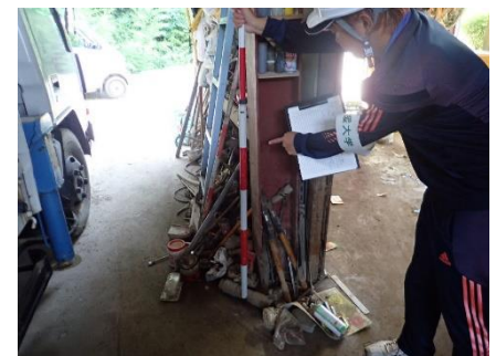
写真 2-8-4 ④工場内の浸水痕跡
