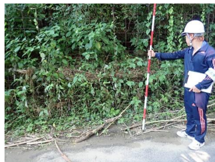
写真 2-8-3 ③山際の浸水痕跡
