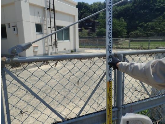
写真 2-4-2 吉田排水機場
