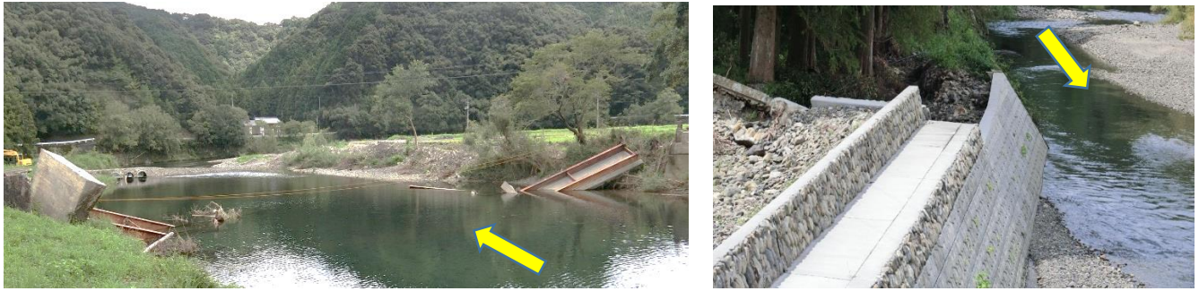
写真 4-2-1 松田川支川である篠川流域における典型的な被害（左：横断橋の流出，右：護岸の損傷）
