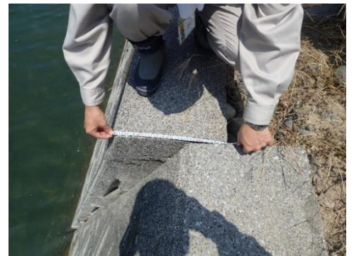
写真 2-5-2 ④楠橋右岸コンクリートブロック
