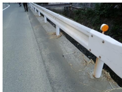
写真 2-6-8 ⑩支流ガードレール支柱
