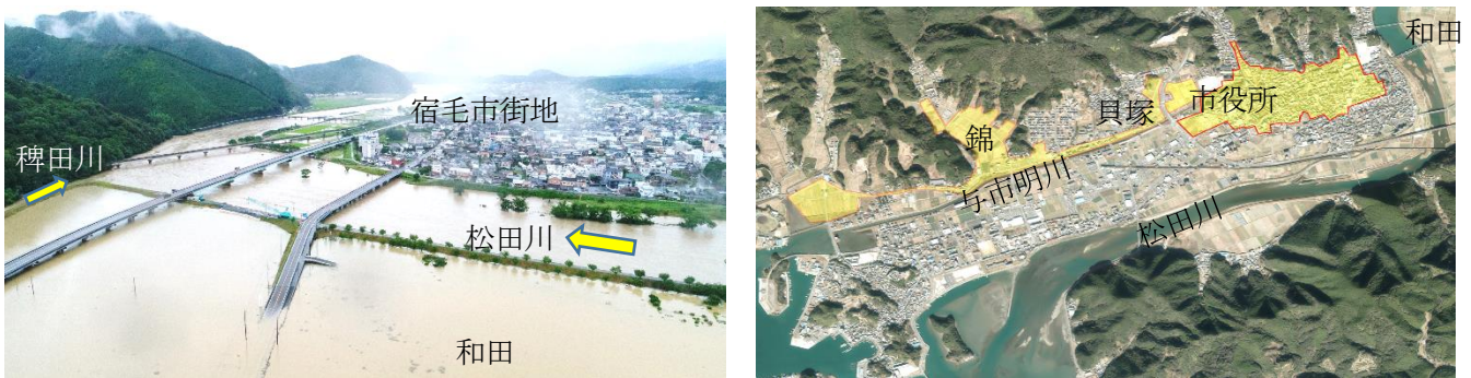
写真 4-2-2 宿毛市の氾濫状況（左：和田地区浸水の様子，右：市街地における浸水範囲，宿毛市提供）
