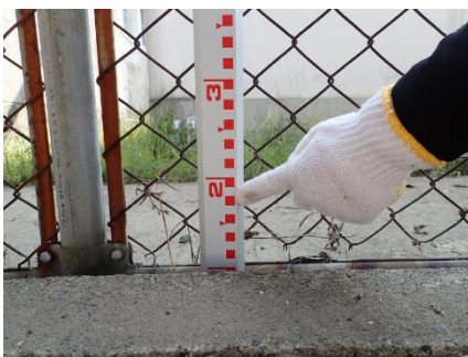
写真 2-6-7 ⑧小学校東側フェンス
