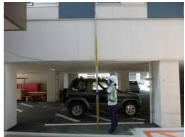
写真 3-4-3 現地踏査の様子
