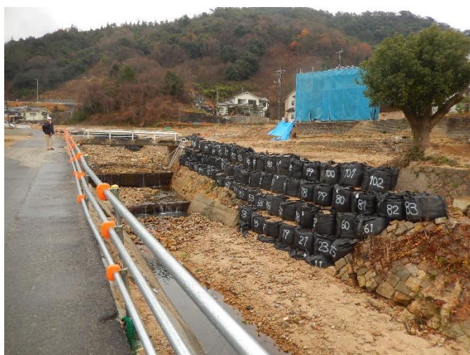
(a) 上流向け(左岸の浸食)
