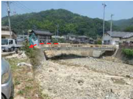
(a) 地点①右岸側（外岸側）越水管所
