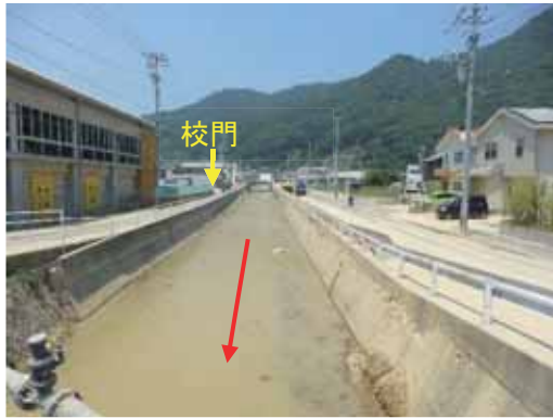
(a) 地点①上流側（右岸側は安浦小学校）
