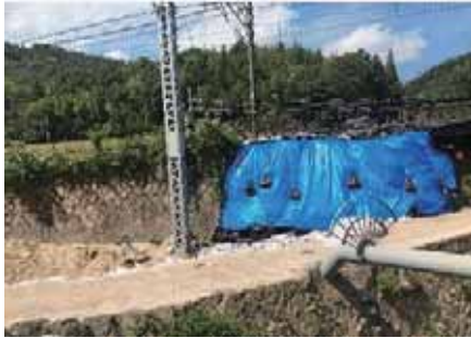
(a) 東広島市八本松での越流による侵食 (ブロック 3) (2018 年 9 月 18 日)
