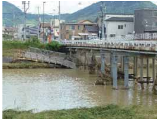
(f) 捕捉された倒壊した真光寺橋 2
