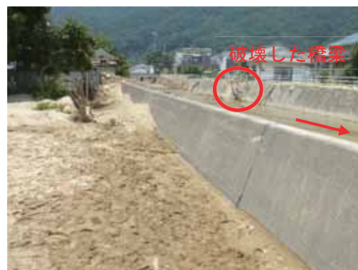
(b) 土砂堆積（右岸）と、橋梁の流失
