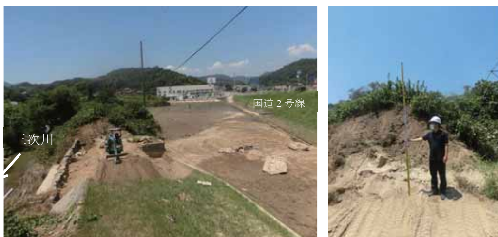
図 4.6.54 三次川左岸の破堤状況
