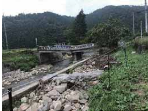
(b) 右岸の越水による侵食と橋脚の沈下（安芸高田市向原坂，図 4.2.3 ブロック 3）
