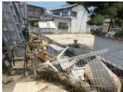
(d) 地点⑥での流木等によるフェンス破損
