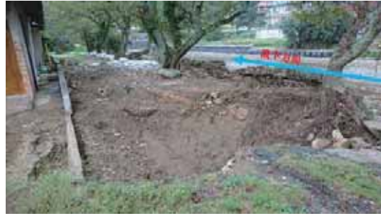
(b) 越流による護岸侵食状況（広島市安佐北区見張）（図 4.2.5 ブロック 22 内）
