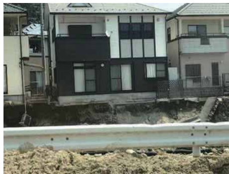
(e) 左岸の侵食 (H6) (2018年7月17日)
