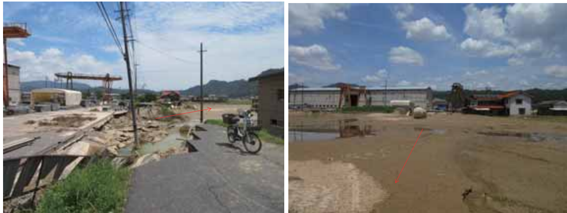
図 4. 6. 23 船木大橋下流右岸工場沿いの道路盛土の崩壊 (図4. 6. 16⑤)
