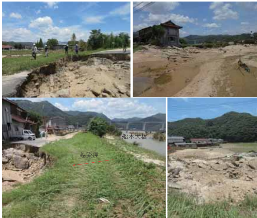
図 4.6.21 船木大橋下流右岸の侵食箇所（図4.6.16②）
