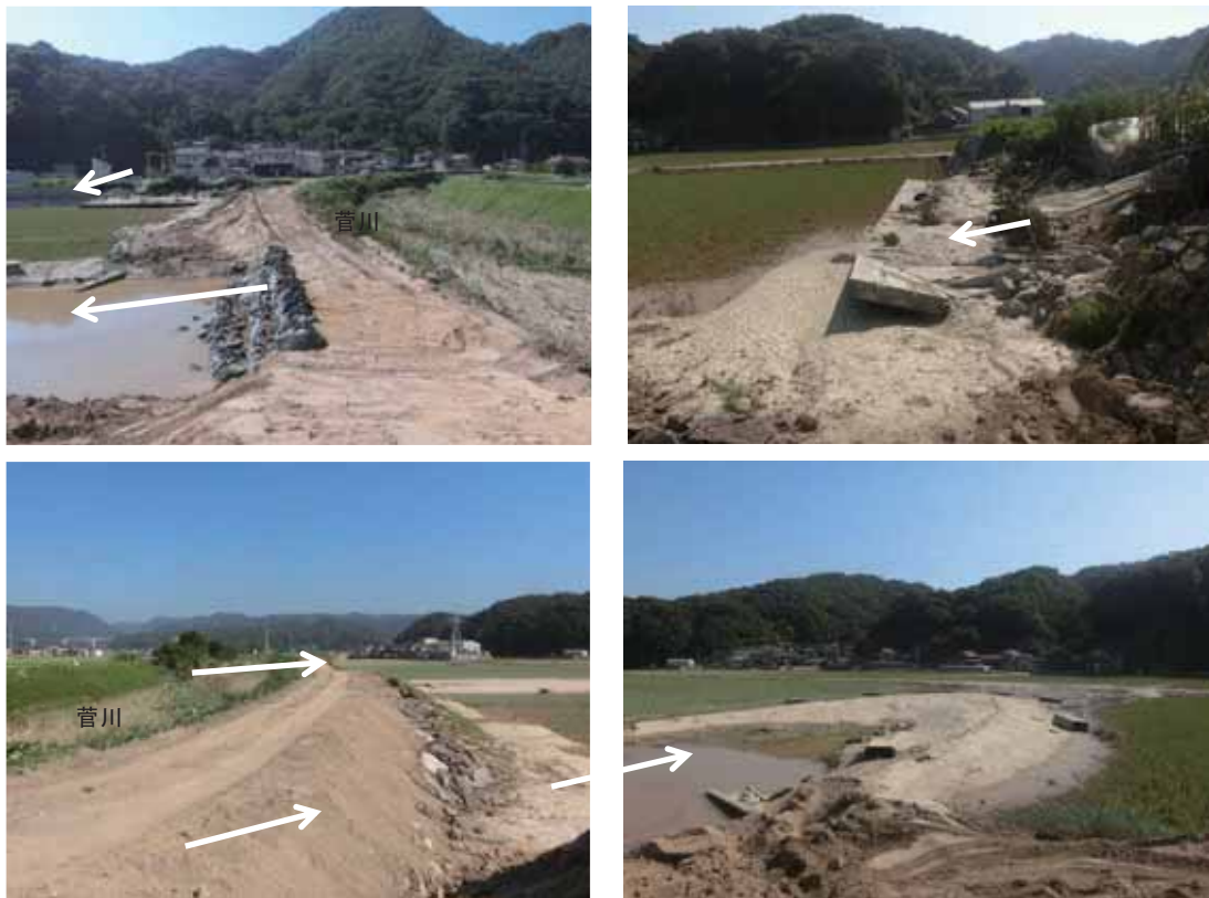
図 4.6.47 菅川左岸の破堤部③
