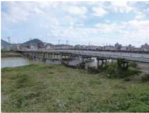
(e) 捕捉された倒壊した真光寺橋 1
