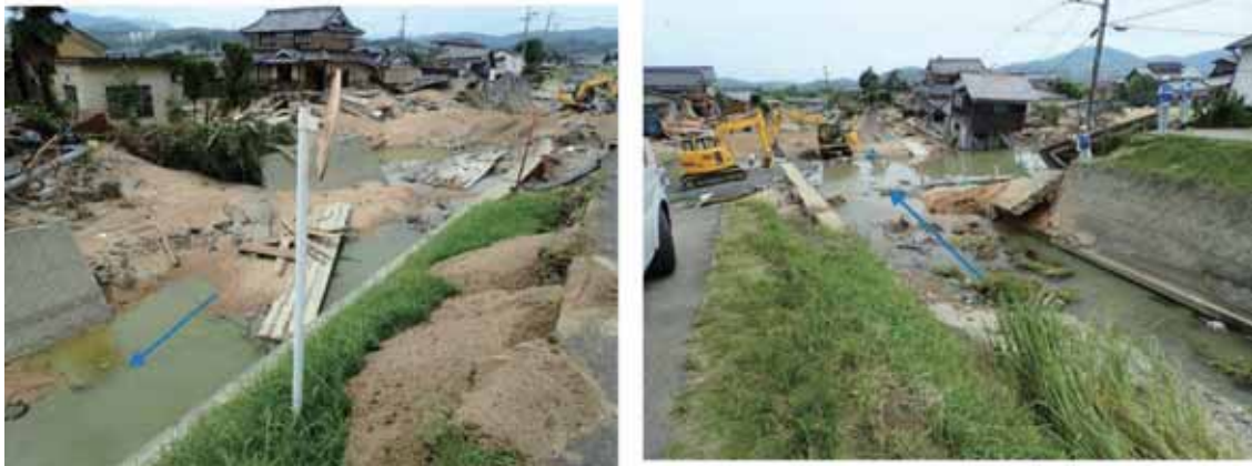
図 3.5.22 末政川 0.7km の堤防決壊状況
