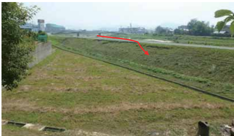
(e) 黒瀬川 (合流点上流側) からの越水の痕跡
