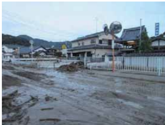
(a) 流木の堆積と周囲の土砂流の浸水 (2010年7月10日)
