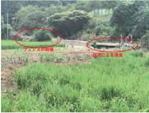
(a) 右岸側への越水痕跡（安芸高田市出口，図 4.2.3 ブロック 1）
