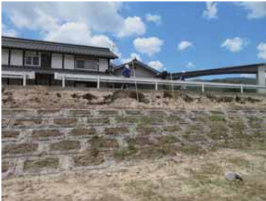
図 4.6.19 船木大橋上流右岸の非越流箇所の侵食被害の様子
