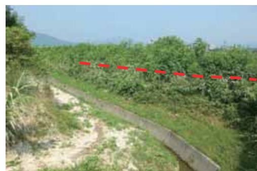
(f) J : 左岸側（裏のり面）の洪水痕跡
