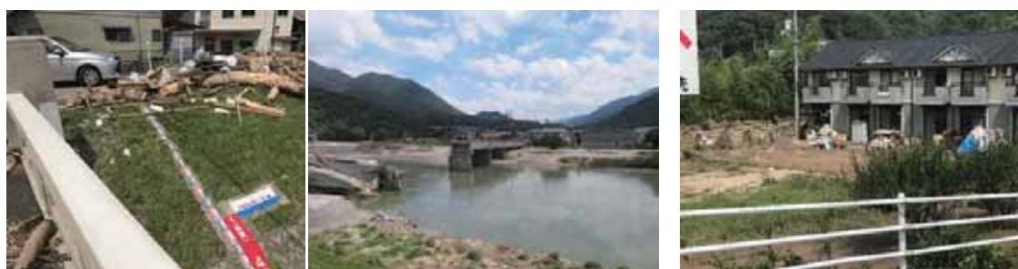
(a) 右岸の越水痕跡
