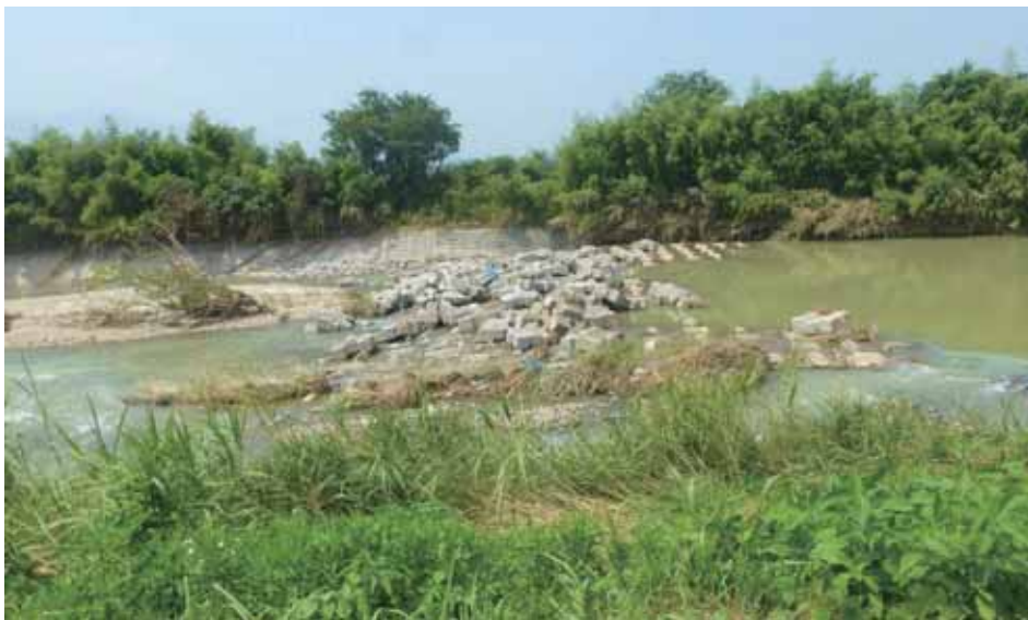
図 4.5.4 黒瀬川中流部（地点①付近）での床固め工の破損状況（7月20日撮影）
