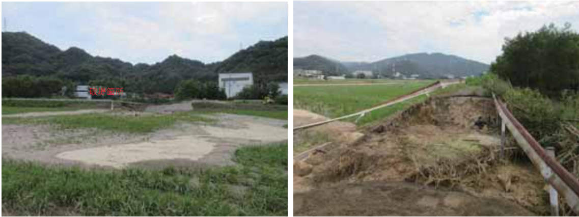
図 4.6.35 天井川破堤箇所の被災後の様子（7月12日撮影）
