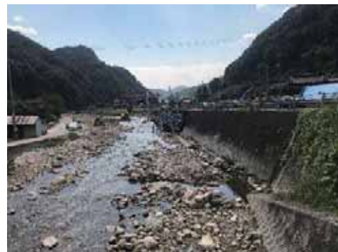
(d) 左右両岸の損傷と礫の堆積状況 (広島市安芸区上瀬野町) (図 4.3.1 の ブロック 18, 19) (2018 年 9 月 18 日)
