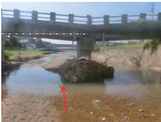
図 4.7.5 A1 地点（橋脚の沈下） （撮影：2018年7月16日）
