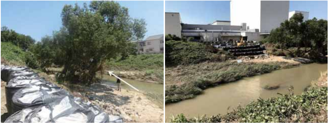
図 4.6.51 梨和川左岸の破堤位置
