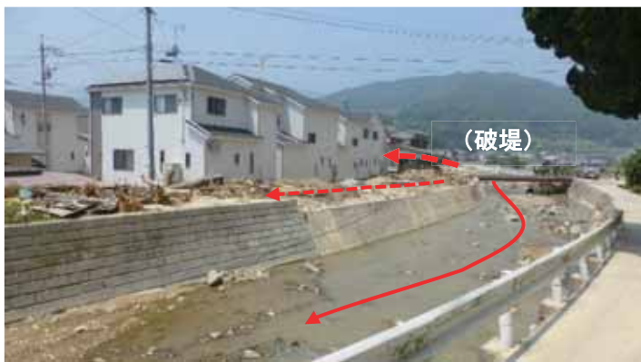
(c) 地点④右岸側での越水，土砂・流木流出の状況
