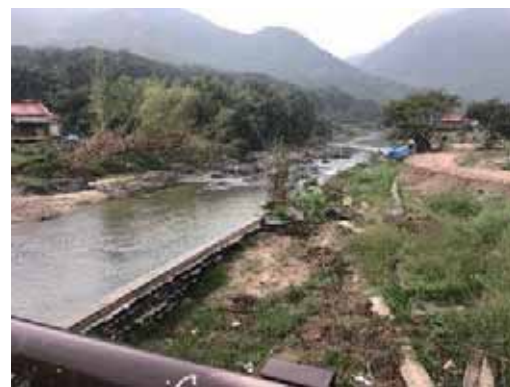
(b) (a) の橋梁下流側の越流による侵食状況（図 4.2.7 ブロック 40）
