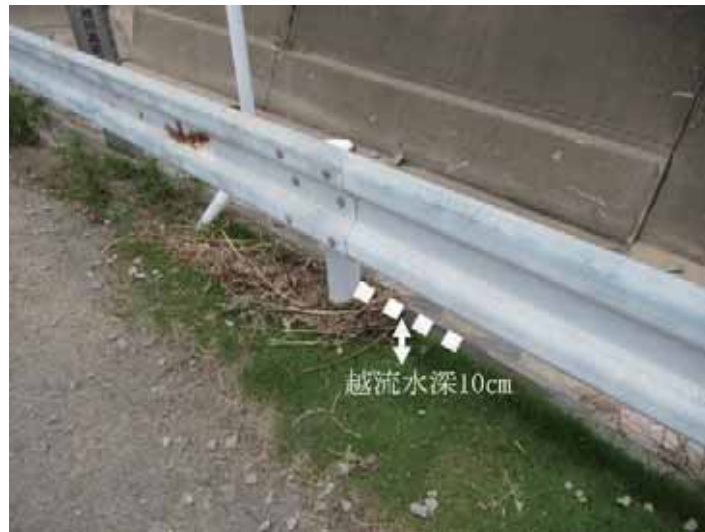
図 3.7.6 高馬川 0.1kp 左岸付近の越水状況
