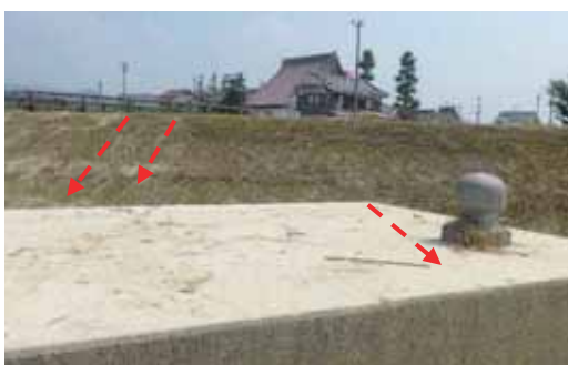
(c) 地点①から約 50m 上流側の痕跡
