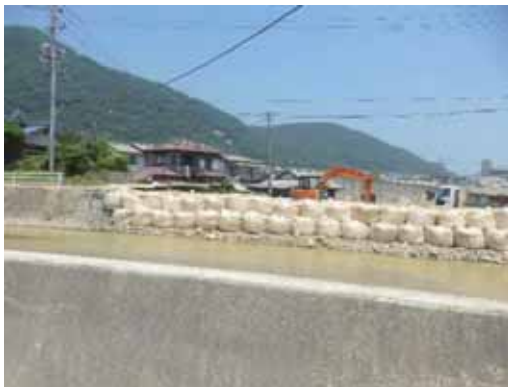
(a) 破堤箇所（上流側）
