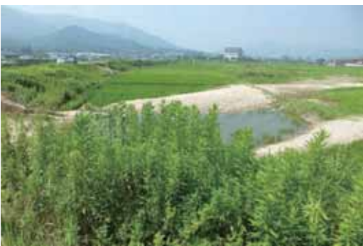
(e) 裏込め土砂の流出（堤防付近）
