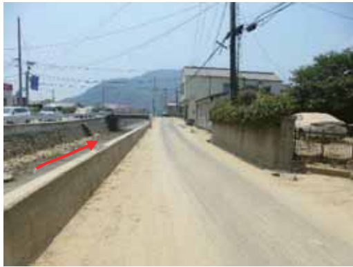
(a) 地点⑤右岸での土砂痕跡（奥：御幸橋）
