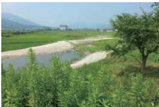
(f) 裏込め土砂の流出（中間）
