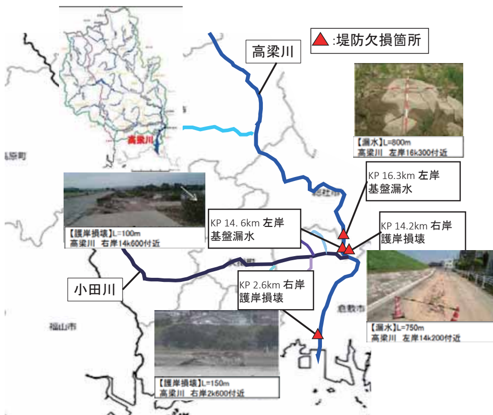
図 3.5.7 高梁川（国直轄区間）における河川の被害状況
