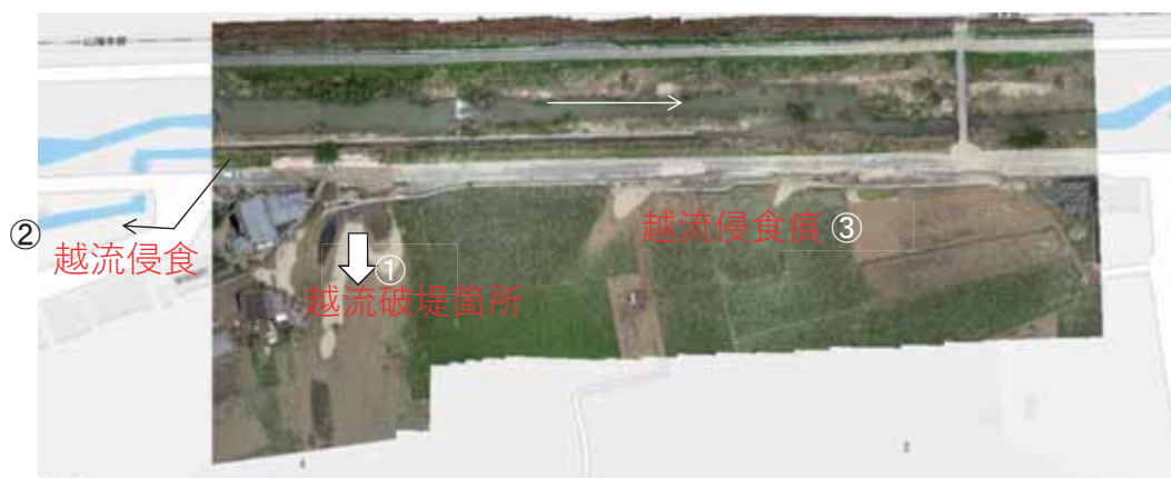
図 4.6.40 仏通寺川破堤付近の被害全景
