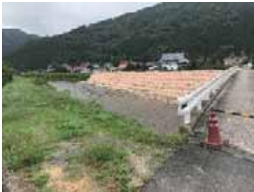
(c) 実重橋（安芸高田市向原隠地）左岸側の堤防損壊に伴う応急対策工の様子（ブロック 8）
