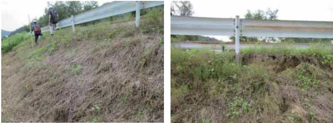
図 4.6.37 破堤部直下流の様子
