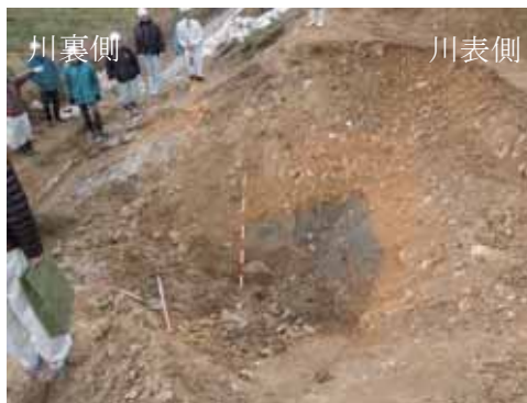
図 5.1.12 開削調査全景
