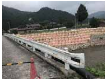
(c) 実重橋（安芸高田市向原隠地）左岸側の堤防損壊に伴う応急対策工の様子（ブロック 8）
