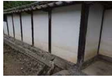
(d) 家屋の塀に付着した浸水痕跡（ブロック 8）
