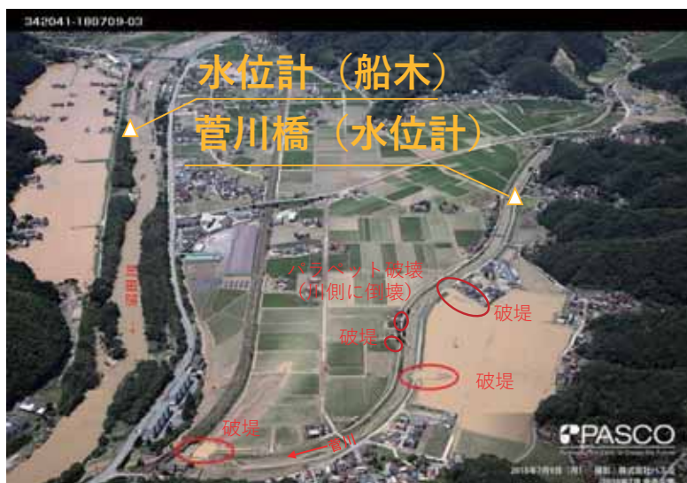
図 4.6.43 菅川合流部付近の被災状況の全景
