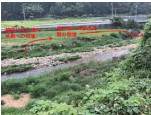
(e) 越水と排水に伴うフェンスの倒壊。安芸高田市向原中組（ブロック 9）
