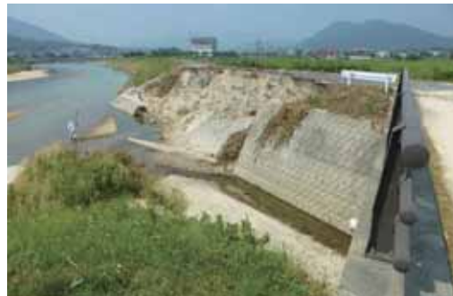
(d) H : 笹野川合流点での護岸の崩落
