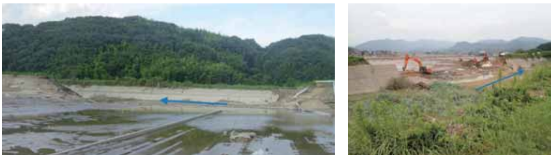
図 3.5.24 真谷川 0.5km 左岸の堤防損壊状況 (左: 左岸堤内地より左岸決壊箇所を撮影, 右: 右岸堤防より左岸決壊箇所を撮影)
