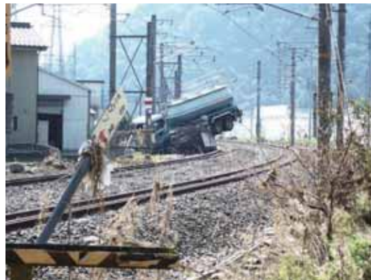
図 3. 5. 32 広瀬地区における浸水状況と線路内に残された大型タンクローリー車
