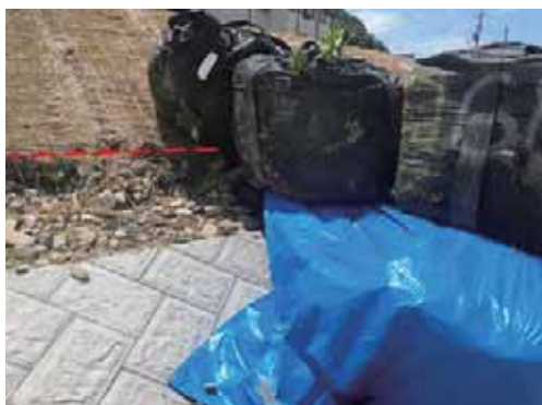
(a) 法面の侵食状況 (2018年7月11日)
