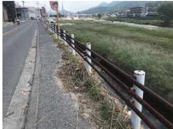
図 4.3.8 海田町畝地区の越水痕跡 (図 4.3.6 のブロック 40) (2018 年 7 月 17 日)
