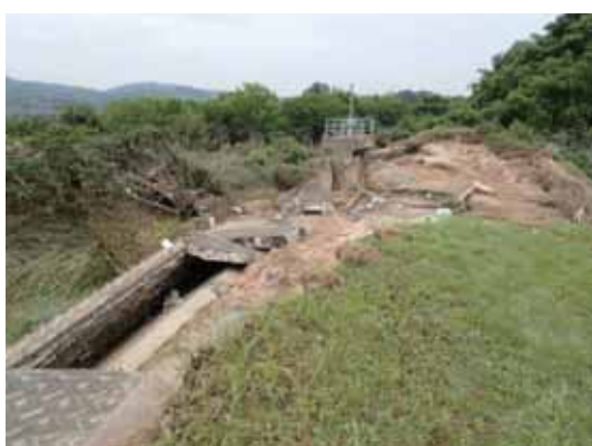
図 3.5.26 真谷川 0km 右岸の堤防損壊状況
