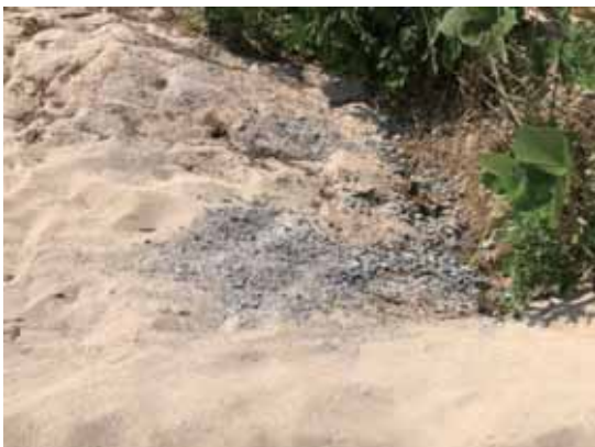
図 5.1.10 置き換え工の砕石の噴出
