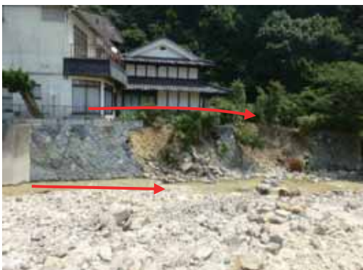
(c) 地点①左岸側での護岸の破壊
