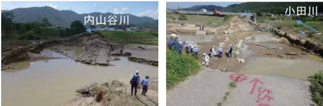
図 3.5.17 小田川 6.4km 左岸地点の堤防決壊状況（左：決壊箇所の下流側（小田川の左岸堤防），右：決壊箇所の上流側（内山谷川の左岸堤防））
