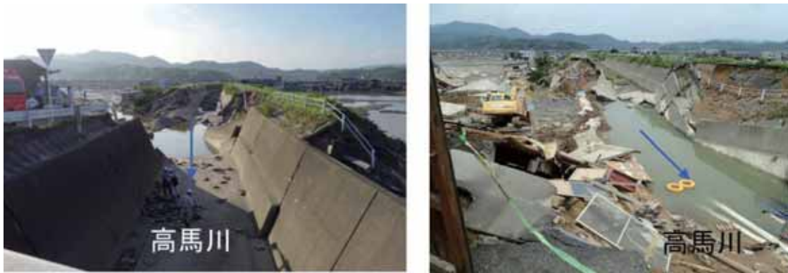
図 3.5.18 高馬川の堤防決壊・損壊状況
