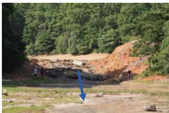
図 6. 2. 4 (a) 堤体の破壊状況
