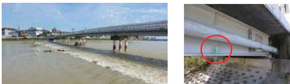
図 4.5.12 日の出橋の床版下部に放置されていたペットボトル（7月9日撮影）
