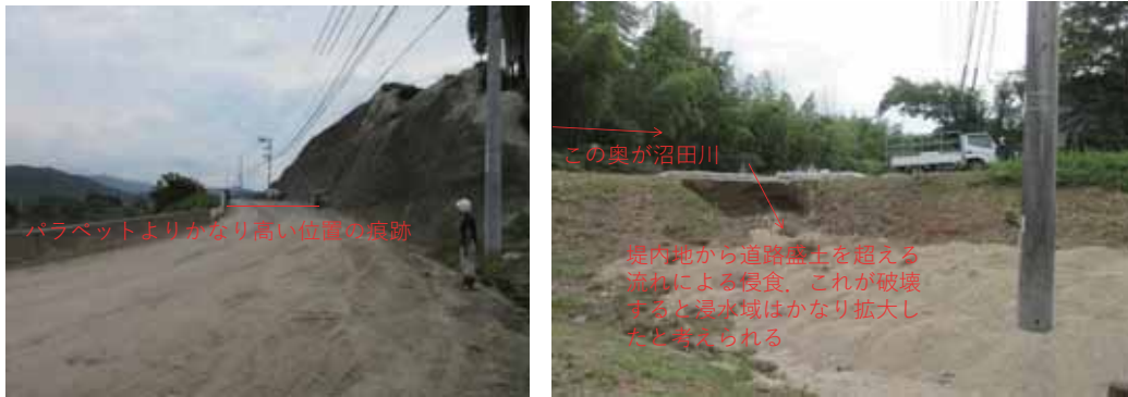
図 4.6.27 茶山涯頭首工上流湾曲部右岸の氾濫被害の様子
