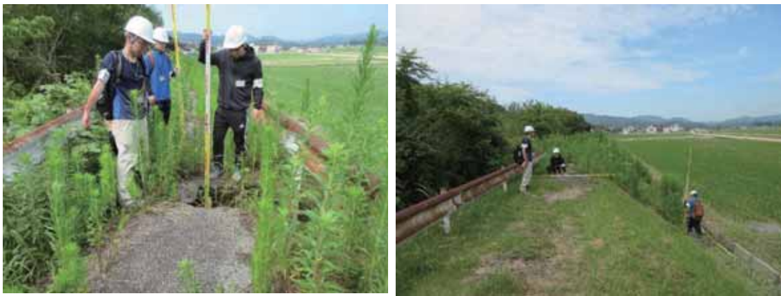
図 4.6.38 破堤部下流の堤防断面変化部
