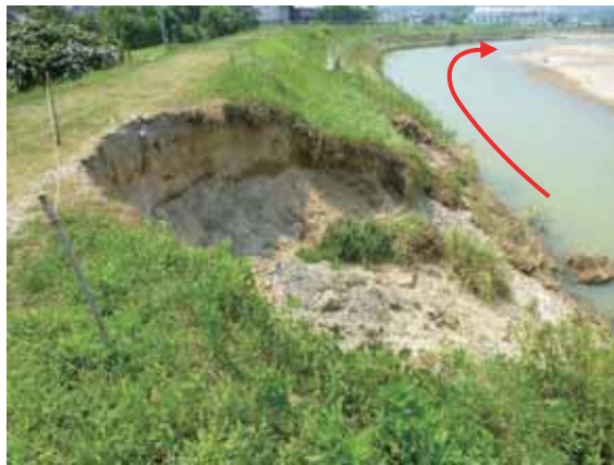
(a) 地点①での表のり面の崩落
