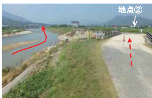
(d) 合流点の橋梁上に土砂 (奥に地点②)
