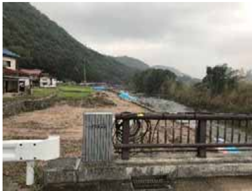
(a) 広島市安佐北区白木町上三田地区、右岸側の越流痕跡、写真左端の家屋の外壁損壊（図 4.2.7 ブロック 40）
