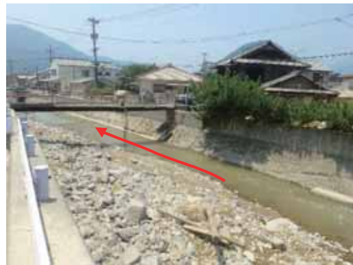
(b) 地点⑤での橋梁高欄の破損
