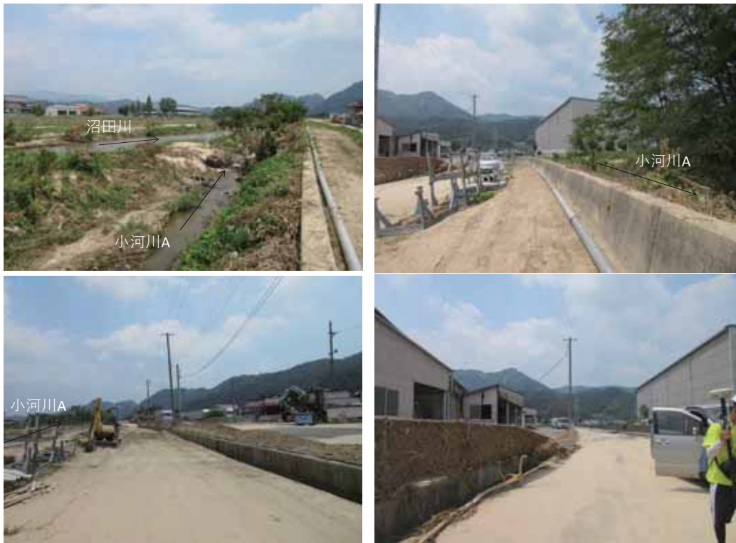
図 4. 6. 22 船木大橋下流右岸小河川からの氾濫被害 (図 4. 6. 16②)
