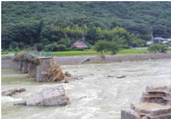
図 4.6.29 橋梁被害の様子(図 4.6.28①)
