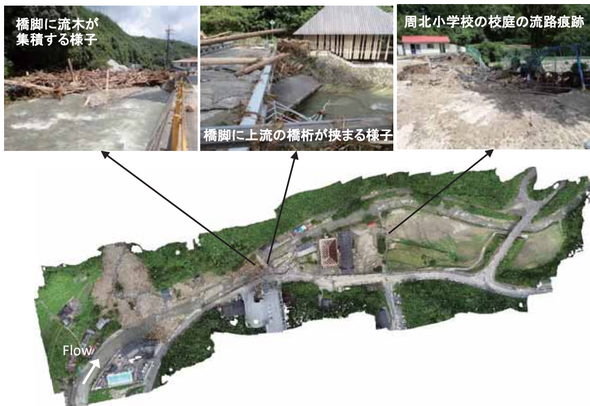
図 5.2.7 瀬越地区の調査対象域のオルソ画像および被災状況
