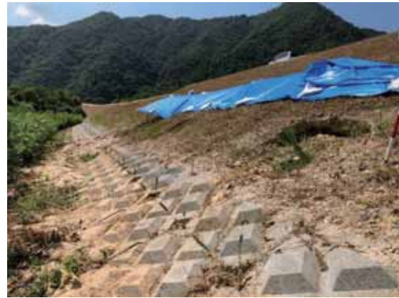
図 5.1.7 堤体の陥没
