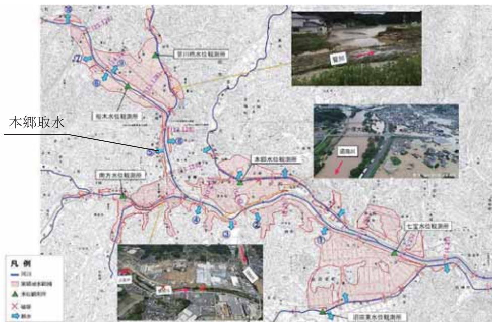
図 4.6.14 沼田川下流域の被災状況 8)
