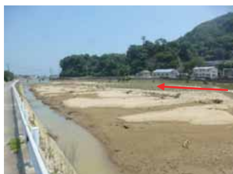
(b) 中切川との合流地点（地点⑤）の様子 (c) 河口付近の土砂堆積の様子
