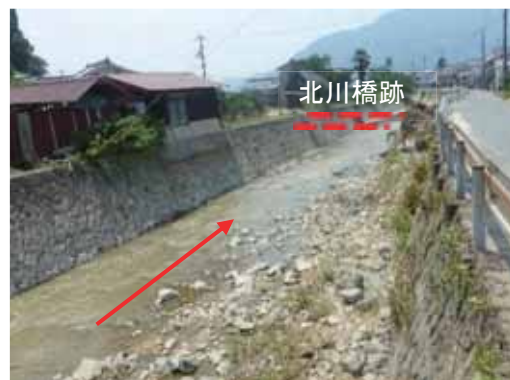
(d) 地点②：橋梁（北川橋）の破壊・流失
