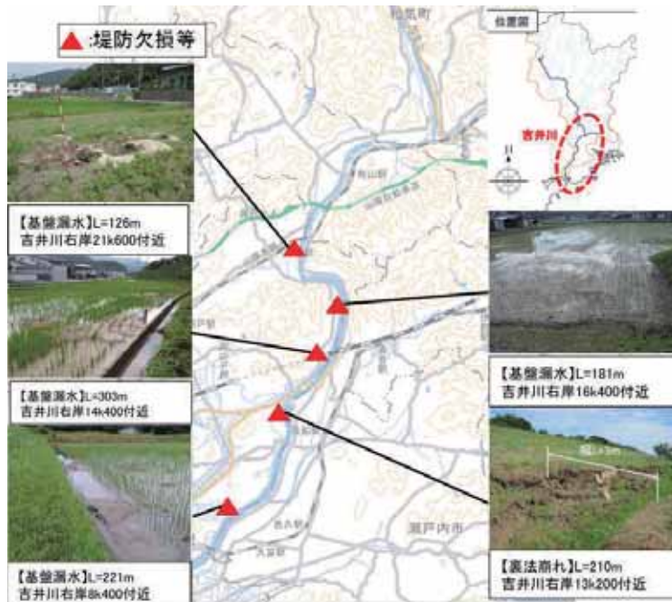
図 3.3.4 吉井川 (国直轄区間) における河川の被害状況
