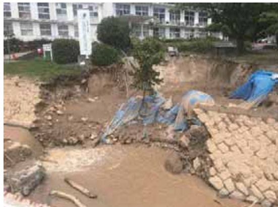
(c) 府中みくまり病院側の侵食状況 (2018年7月11日)
