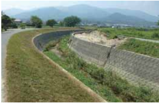
(a) 崩壊部分の上流側
