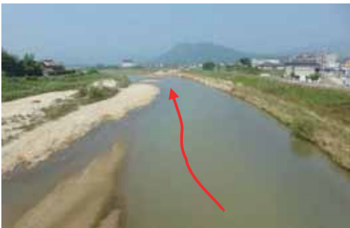
(c) G : 砂州・流路と護岸崩落地点
