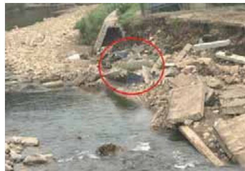
(f) 護岸損壊による右岸の侵食。太陽光発電システムの被害（○枠内）安芸高田市向原中組（ブロック 11）
