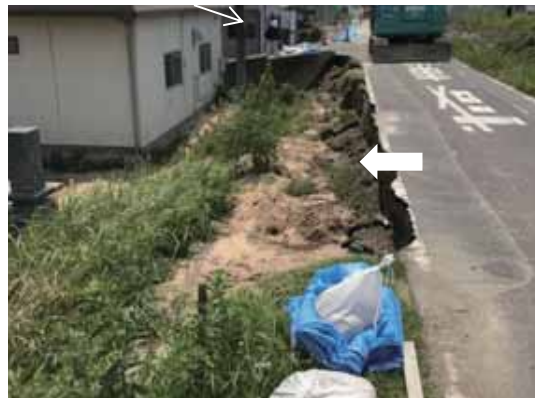
図 4.8.13 A1-2 地点での越流による堤内地の路肩の侵食 （撮影：2018年7月16日）
