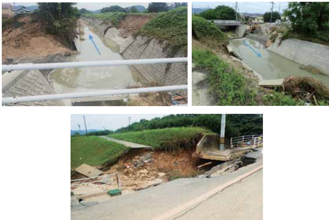
図 3.5.20 末政川 0.4km 左岸の堤防決壊・損壊状況（左上：橋より下流を撮影，右上：下流右岸より上流を撮影，下：橋の右岸側より堤防裏法崩れの様子を撮影）
