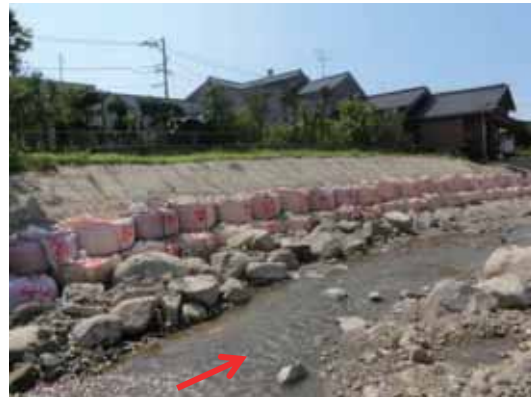
図 4.7.6 A2 地点（護岸の崩壊） （撮影：2018年7月16日）
