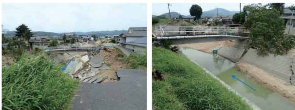
図 3.5.21 末政川 0.6km の堤防損壊状況
