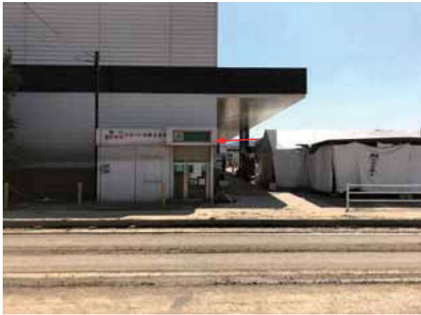
図 4.6.52 梨和川右岸堤内地の浸水痕跡
