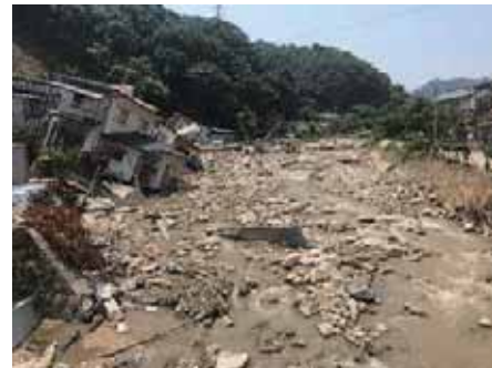
(d) 合流点付近の右岸側の河床侵食と堤外地側に転倒した家屋 (H12) (2018年8月29日)
