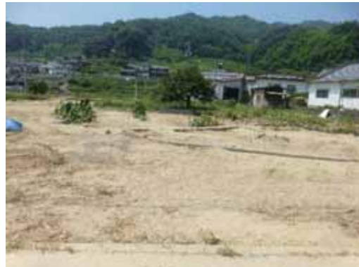
(b) 地点①右岸側での土砂流出の状況
