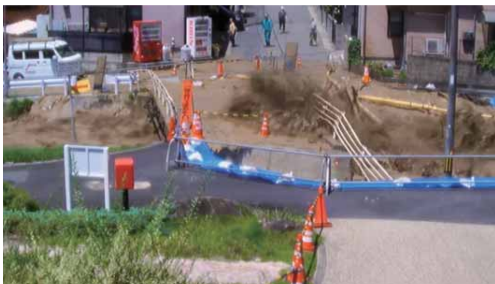
図 6.3.2 防犯カメラで記録されたみくまり病院前の氾濫の様子（みくまり病院提供）
