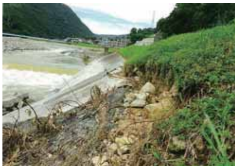
(c) 左岸側での侵食（7日11時頃）
