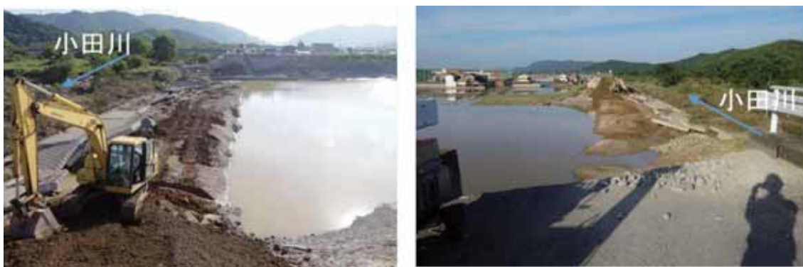
図 3.5.16 小田川 3.4km 左岸地点の堤防決壊状況 (左：決壊箇所の下流側, 右：決壊箇所の上流側)
