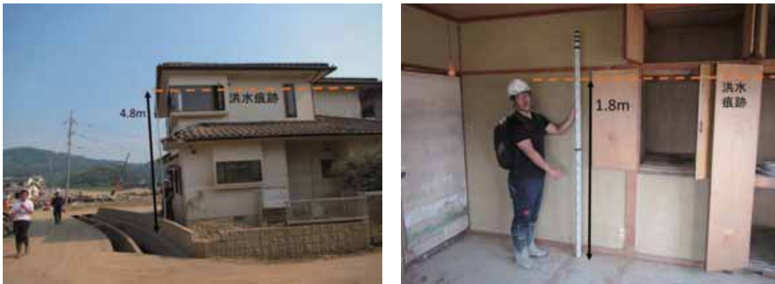
図 3.5.14 真備地区での浸水痕跡 (浸水深 5m の民家, 7/17, 7/18 合同調査結果)
