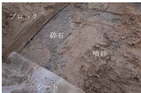
図 5.1.14 噴砂の侵入状況
