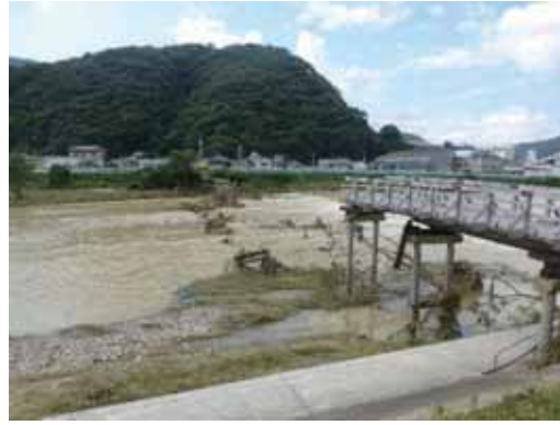
(b) 真光寺橋全景（左岸から撮影）
