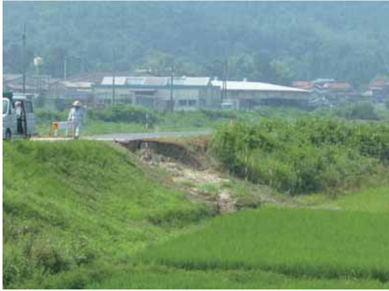
図 4.5.16 堤防の崩壊箇所：地点②の様子（7月20日撮影）
