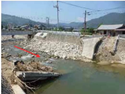
(a) 野呂川（地点⑦）での橋梁の損壊
