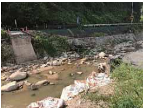
(c) 護岸損傷と橋梁流失 (広島市安芸 区上瀬野町) (図 4.3.1 のブロック 11, 12) (2018 年 9 月 18 日)
