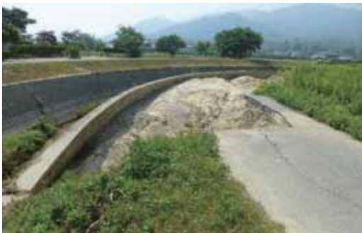
(c) 崩壊部分の裏込め
