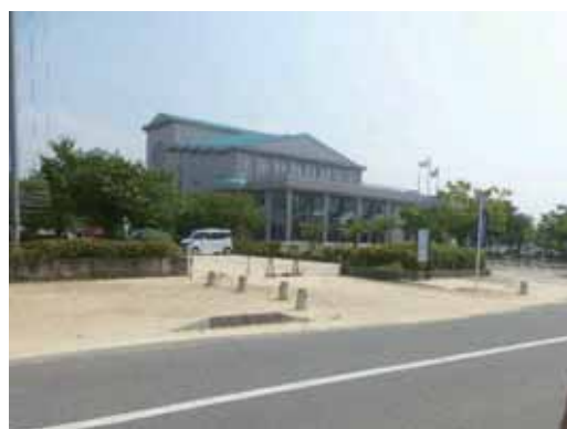
(c) C : 図書館入口付近の土砂の堆積
