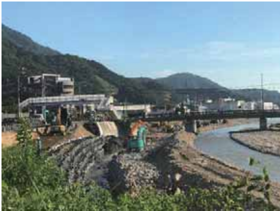
図 4.3.7 中野東の国道 2 号線の堤防損 壊 (2018 年 7 月 14 日)
