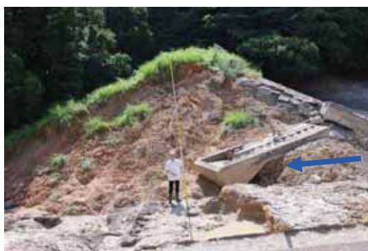
図 6. 2. 4 (b) 堤体右岸側の破壊状況
