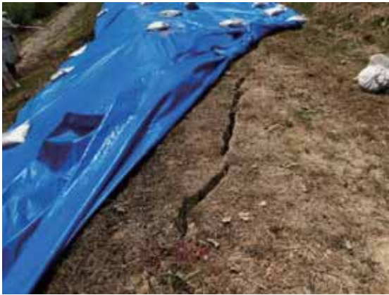
図 5.1.6 堤体の法すべり
