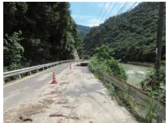
図 4.6.30 斜面崩落による被害(左, 図 4.6.28②)と 湾曲部外岸の道路陥没(右, 図 4.6.28③)
