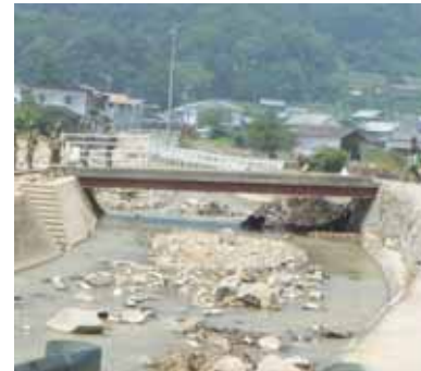
(d) 橋梁高欄の破損・流失
