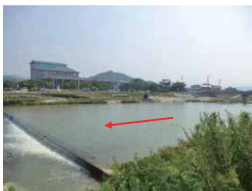
(a) A : (左岸側から) 床固め, 図書館
