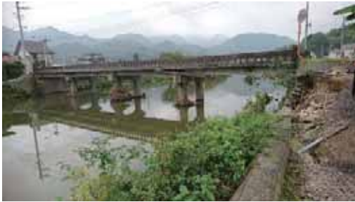
(c) 県道 46 線柏木橋に付着した流木と右岸の侵食（図 4.2.5 ブロック 26）
