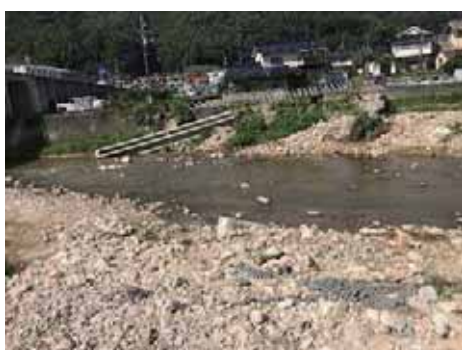
(a) 上瀬野南での橋梁流失 (2014年7月14日)
