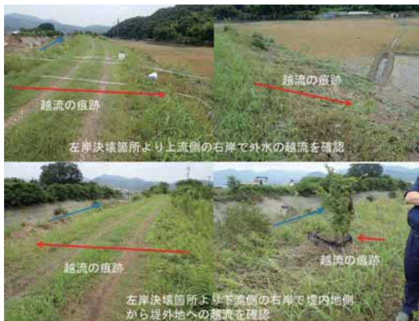
図 3.5.25 真谷川 0.5km 右岸側での越流痕跡状況
