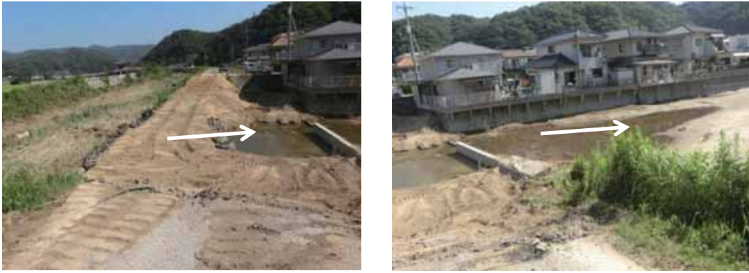
図 4. 6. 48 菅川左岸の破堤部④
