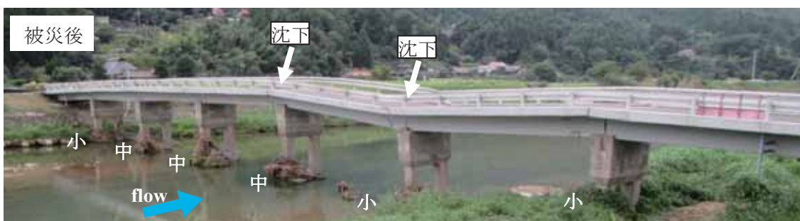
(a) No. 47（高瀬橋）
