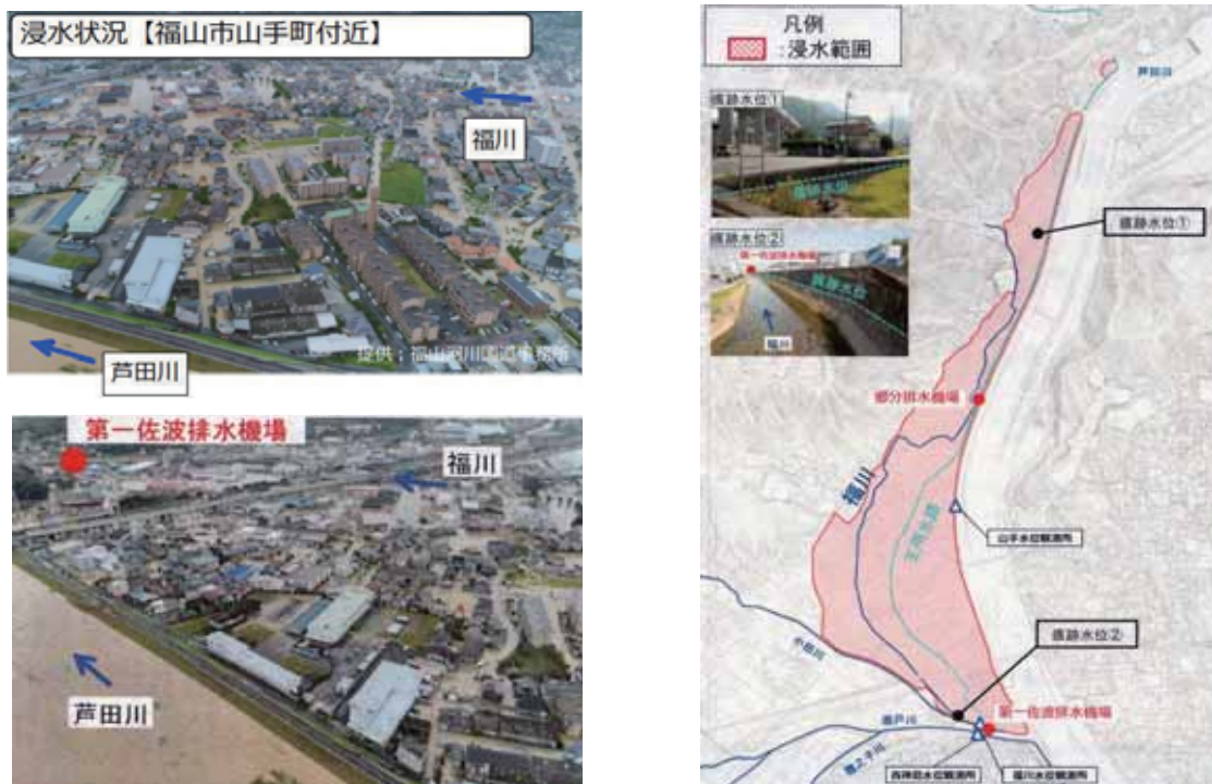
図 4.8.5 福川周辺での浸水状況
