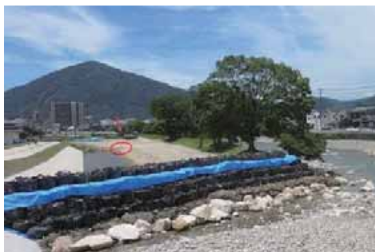
(b) 土嚢下流側の窪みと溢水痕跡（赤丸の範囲内）(2018年7月11日)
