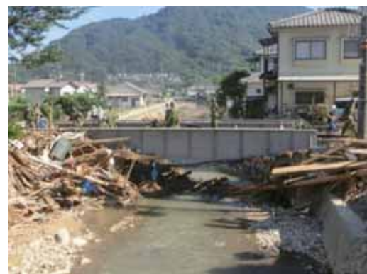
(d) 鉄道橋の流木撤去前の状況
