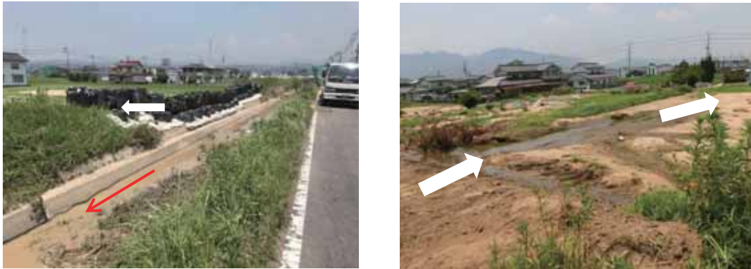
図 4.8.12 A1-1 地点での被害状況（左：破堤，右：氾濫後の土砂堆積） （撮影：2018年7月16日）
