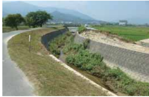
(b) 崩壊部分の下流側
