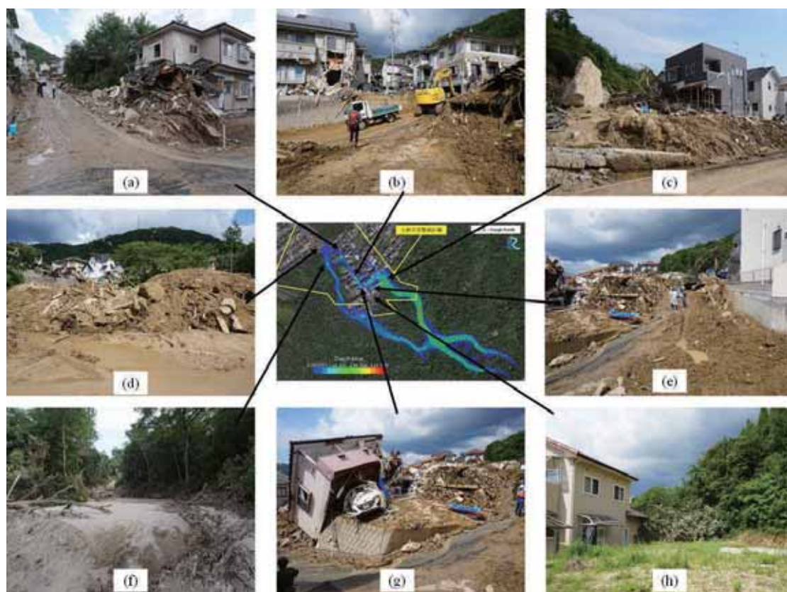
図 6.1.4 土石流による浸食・堆積の様子
