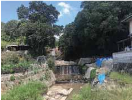
(a) 砂防堰堤直下の越流による被害 (H26) (2018年8月29日)
