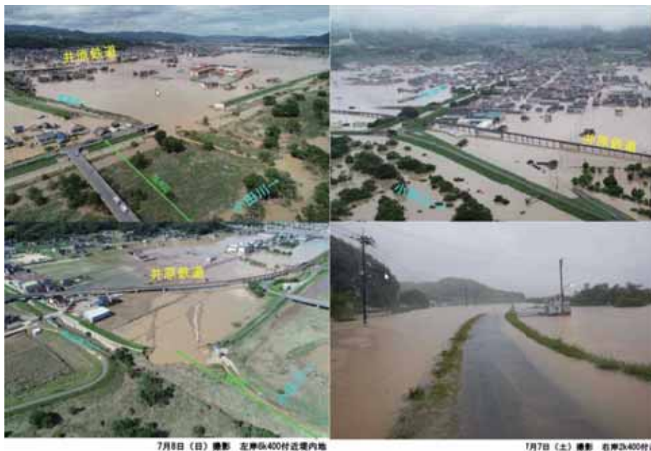
図 3.5.12 真備地区における浸水被害状況（今次豪雨，国土交通省中国地方整備局提供）
