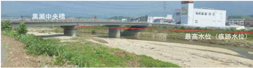
図 4.5.7 黒瀬中央橋の上流左岸側（地点 A 辺り）から下流側を撮影
