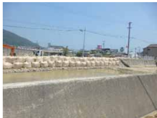
(b) 破堤箇所（下流側）
