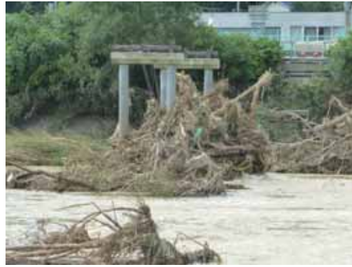
(d) 橋脚の流木等の捕捉
