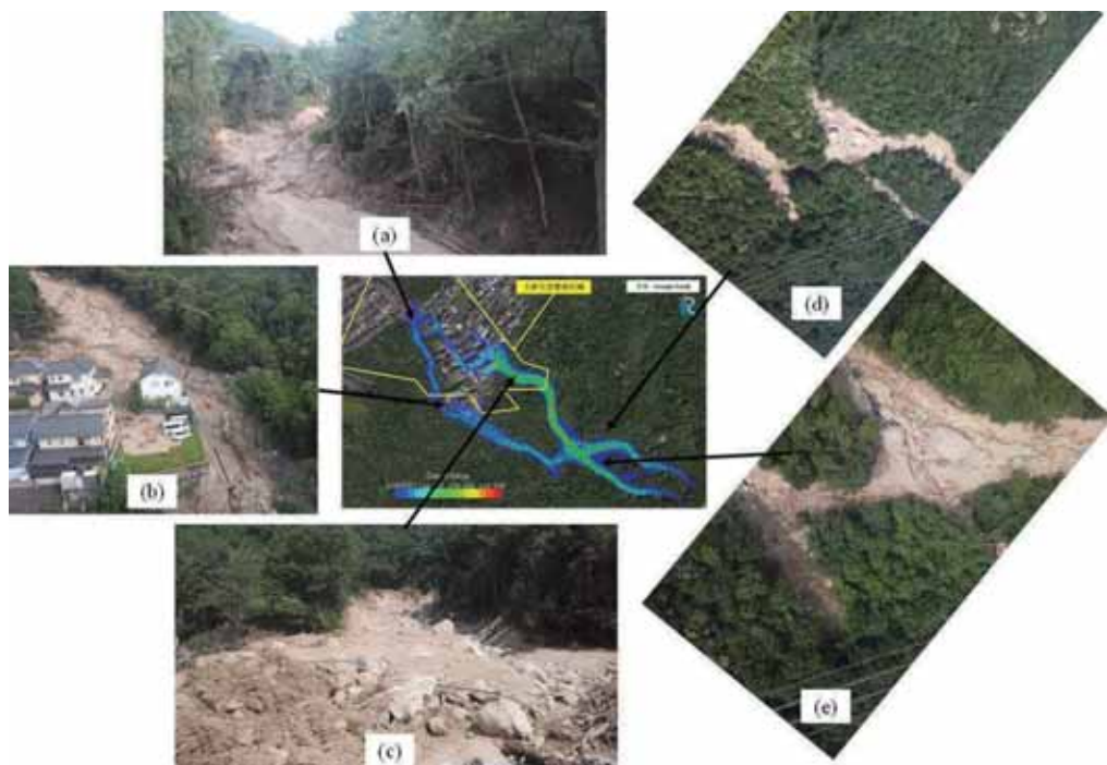
図 6.1.3 土石流による浸食・堆積の様子
