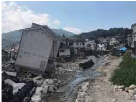
(c) 地盤の侵食による消防団出張所の被害 (H20) (2018年8月29日)
