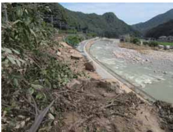
図 4.6.30 斜面崩落による被害(左, 図 4.6.28②)と 湾曲部外岸の道路陥没(右, 図 4.6.28③)
