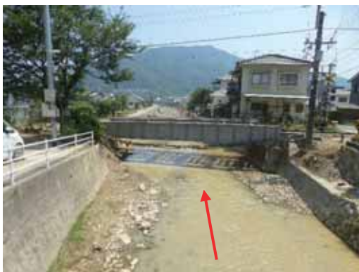
(c) 地点①下流側（正面：JR 呉線鉄道橋）
