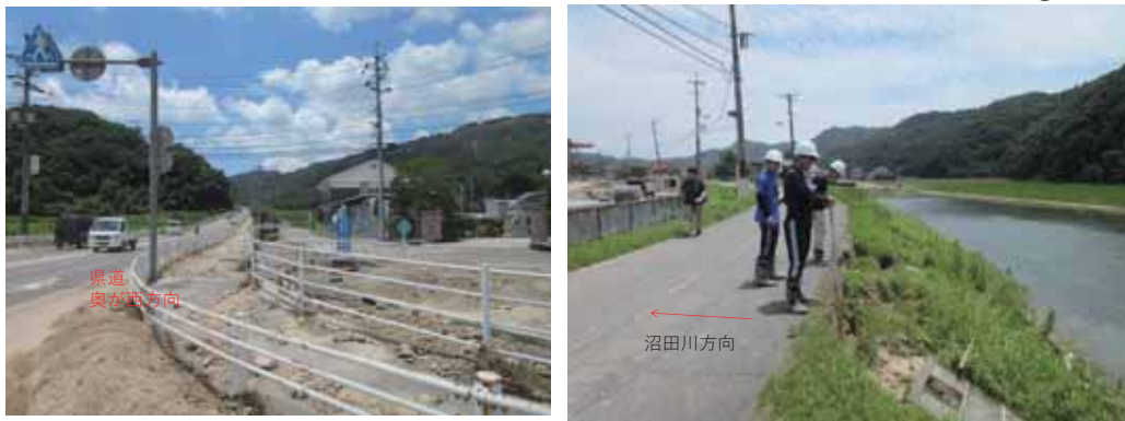
図 4. 6. 24 船木大橋下流右岸氾濫水の上流氾濫域への拡大 (図4. 6. 17⑥)
