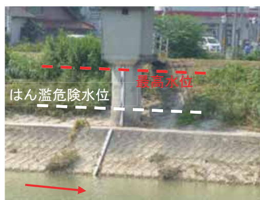
(b) B : (右岸側から) 松ヶ瀬水位観測所
