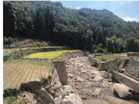
(b) 左岸側の護岸の損壊状況 (ブロック H25) (2018年8月29日)
