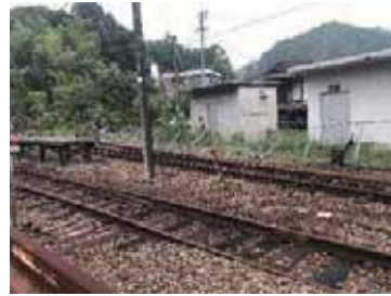
(d) 志和口駅構内のフェンスの倒伏（図 4.2.5 ブロック 26）
