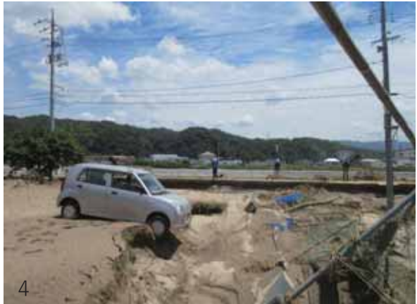
図 4.6.18 船木大橋上流右岸の侵食被害の様子。越流侵食箇所は4か所で下流から順に番号を付けている。
