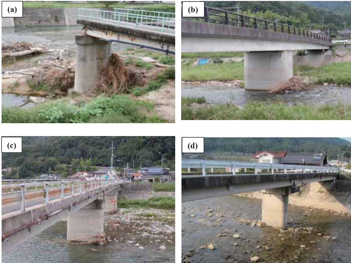
図 4.11.3 流速捕捉状況（捕捉大(a)，中(b)，小(c)，極小(d)）
