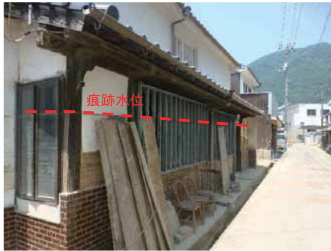
図 4. 4. 10 中畑川下流部（地点③）の被災状況（7月20日撮影）
