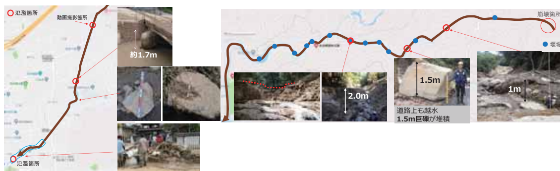
図 6.3.5 洪水・土石流の痕跡状況
