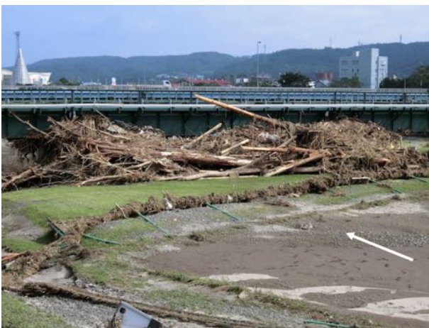
写真 4-2 JR 八戸線の鉄道橋上流左岸側に堆積した流木
