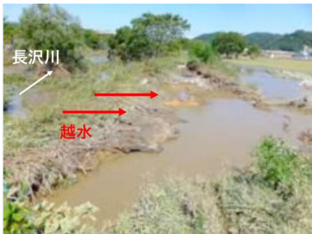
写真 5-3 閉伊川支川長沢川における越水後の被災状況(撮影日：H28.8.31) 5)
