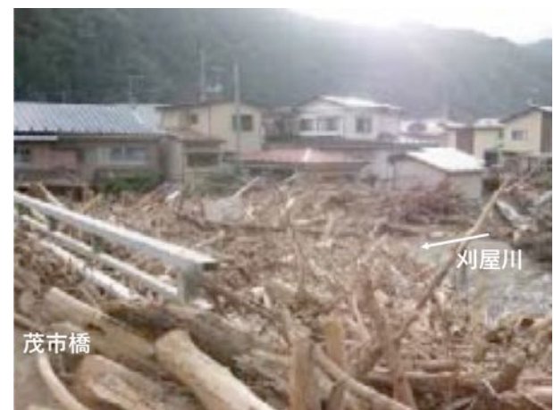
写真 5-5 閉伊川支川刈屋川における日陰橋の落橋(上段)および大量の流木が堆積した茂市橋(下段) 5)
