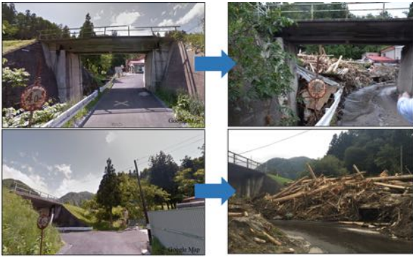
写真 7-1 対象の沢の狭窄部の様子(左は被災前, 右は被災後)
