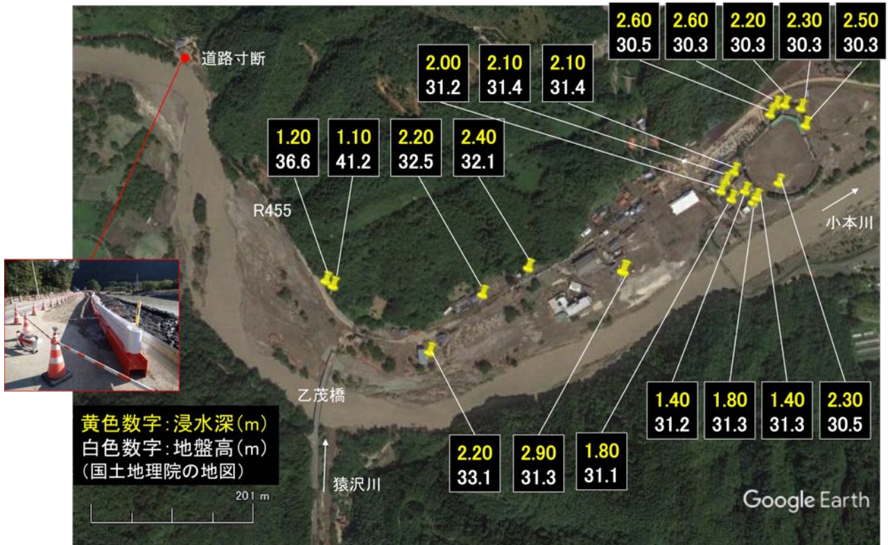
図 3-4 岩手県岩泉町乙茂地区における被害状況
