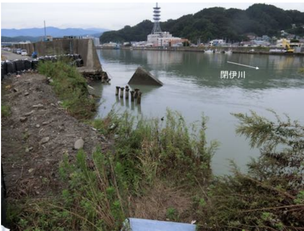
写真 5-1 閉伊川河口部の右岸における被災した堤防
