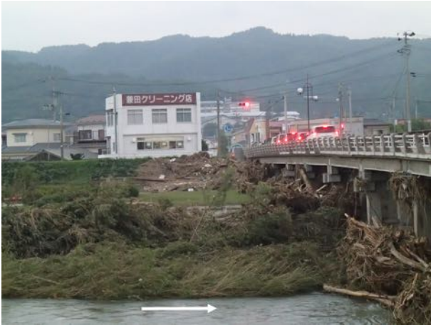
写真 4-1 上の橋の橋脚に堆積した流木
