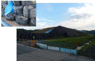
図-10 堤防未整備区間への土嚢設置と設置された土嚢
