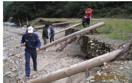
(a) 田畑に個別バラバラで氾濫堆積した流木
