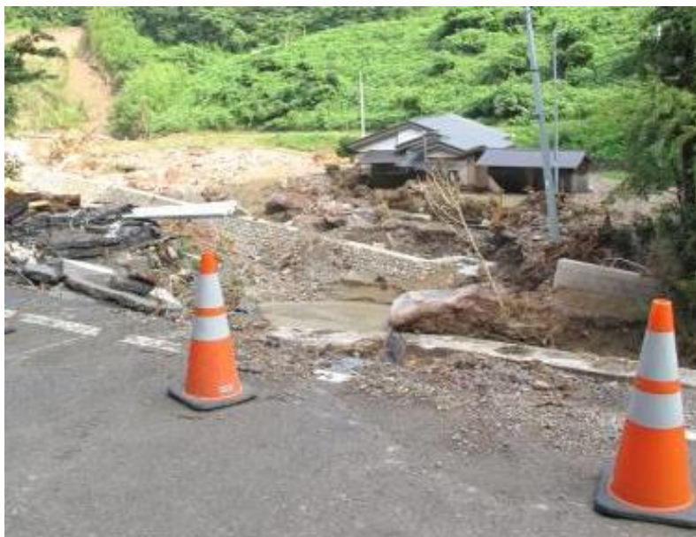
写真 6-3 住宅への道がなくなり災害ボランティアを投入できない状況
