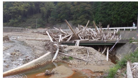
(b) 橋梁に捕捉され群を形成した流木
