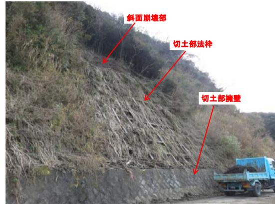
図5.8-3 切土側の擁壁、法枠工と崩壊
