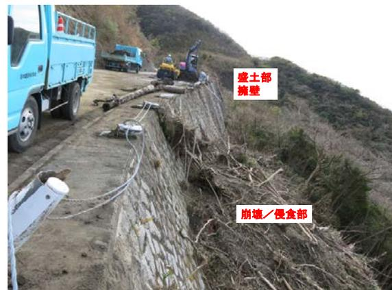
図5.8-5 切土側の擁壁、法枠工と崩壊
