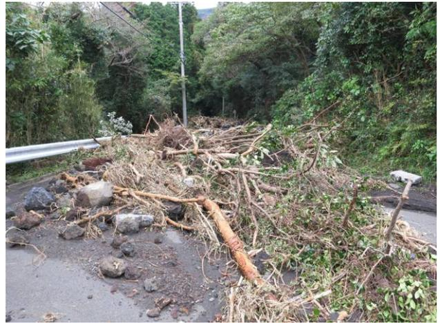
図5.8-15 道路上に堆積した倒木、土砂
