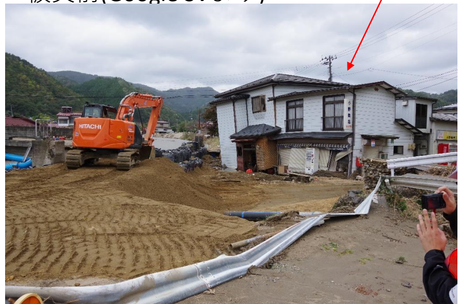
橋梁直情左岸の状況
