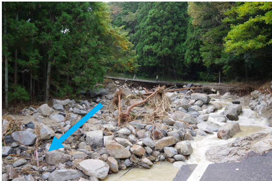
道路のり崩壊地点
