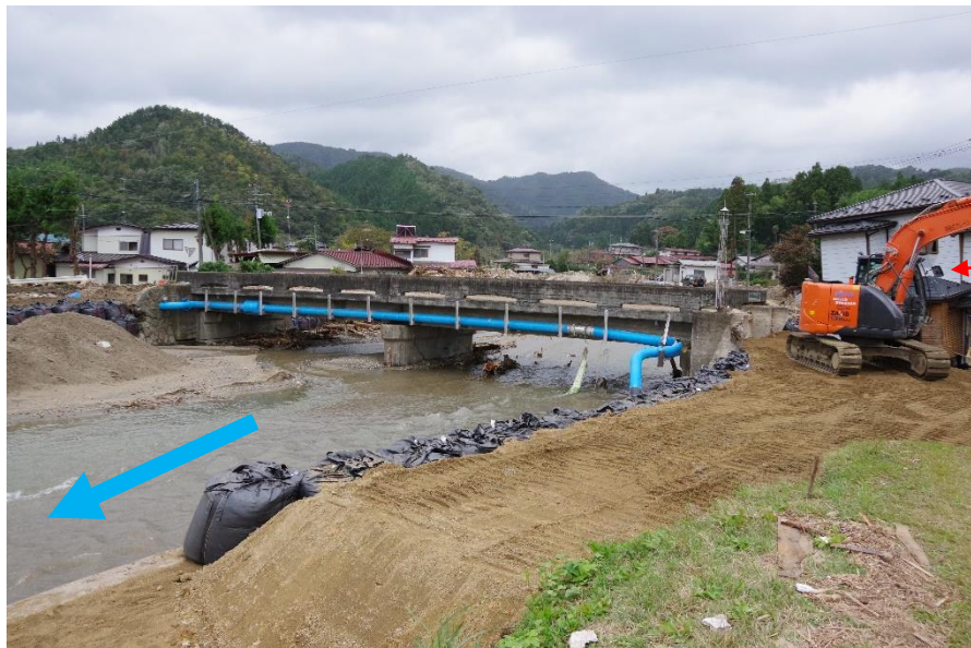
被災橋梁（五福谷橋）
