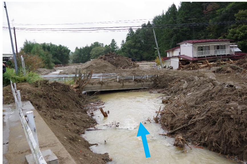
橋梁の閉塞が起こったと推定される
