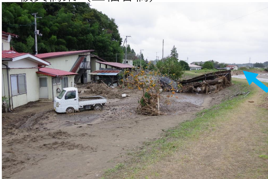
橋梁直下左岸の状況
