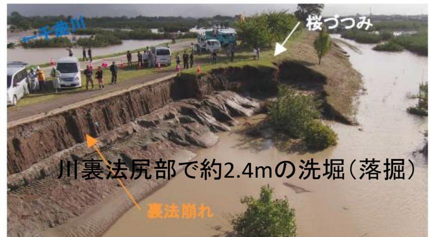
川裏法尻部で約2.4mの洗堀(落掘)
