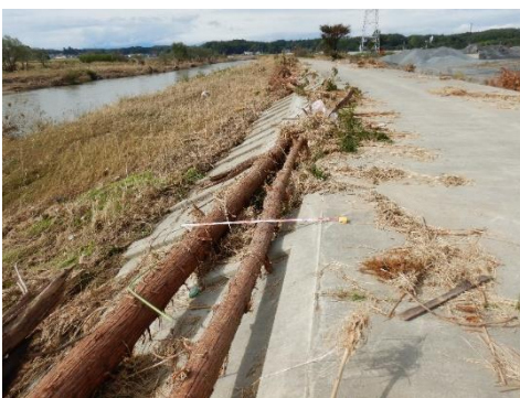
II. 護岸堤防の状況
