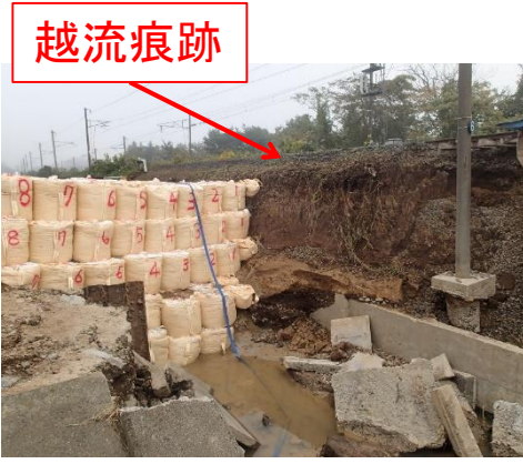
II. 堤防天端上での越流痕跡
