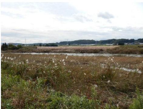
I. 決壊した堤防
