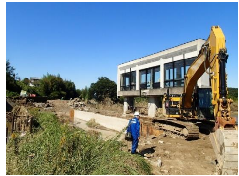
I. 決壊した堤防 (応急復旧中)
