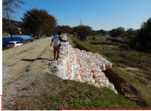
堤外側のパイピング
