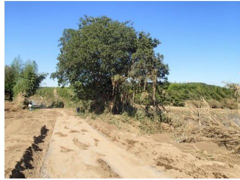
II. 決壊した堤防 下流側の越流痕跡
