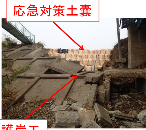
I. 決壊した堤防と護岸破損状況(川裏へ押出)
