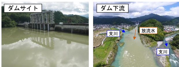
写真 1 H30.7 出水後の状況
