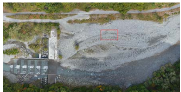
写真-1 作成したオルソ画像の抜粋と解析対象(赤枠内)。
