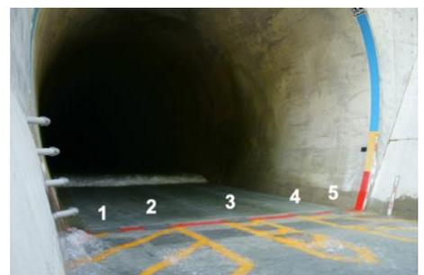
図-1 小渋ダムに設置されたインパクトプレート, (a) 正面, (b) 背面
