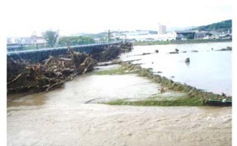
図-2 久慈川 JR 鉄橋に捕捉された流木<sup>2)</sup>
