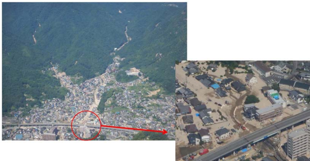
平成 3 0 年 7 月豪雨における土砂・洪水氾濫の発生状況（広島県呉市天応西条地区） 3
