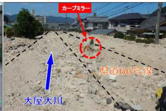
被災後状況写真
