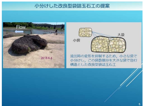
図-2(1).3 小分けした改良型袋詰玉石工
