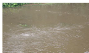
漏水状況(内水湛水面に湧きあがりの湧が発生)
