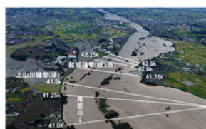
被災時の鬼怒川(上山川地区)の状況
