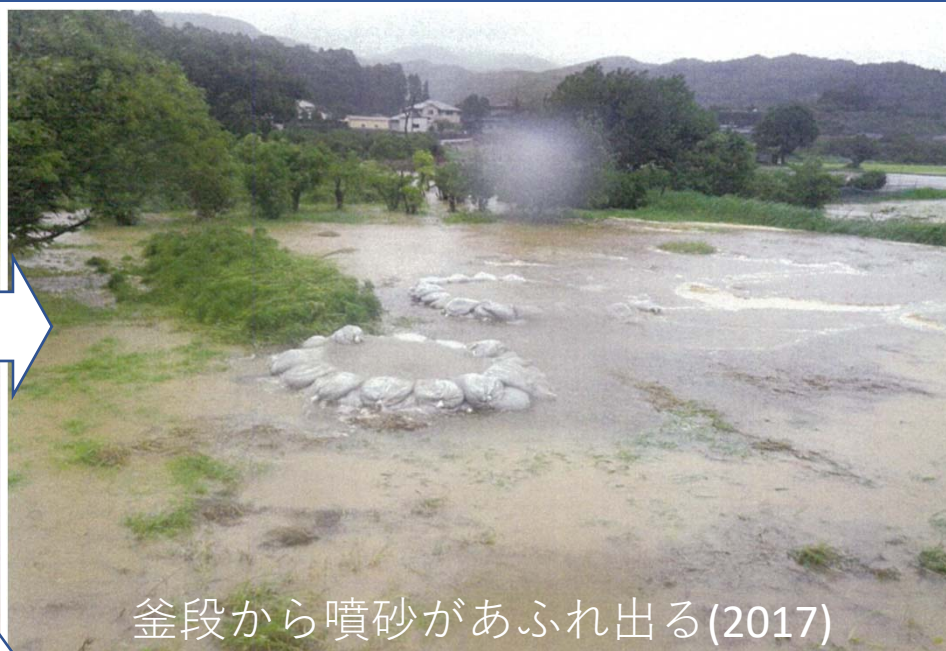
釜段を作るも至る所から漏水・噴砂(2017)
