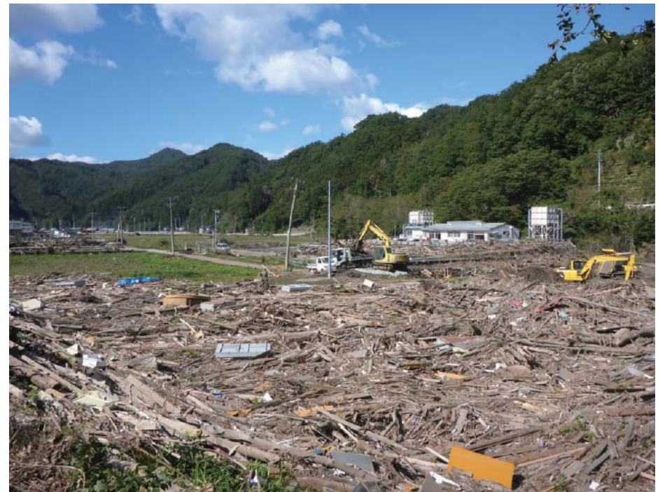
写真 3. 2-31 小本川、中島地区の流木堆積状況
