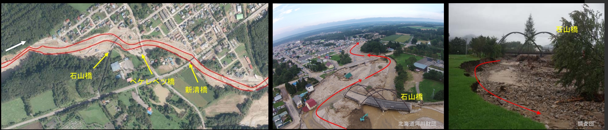
図：上流側と下流側の被災区間の流路変動の違い
