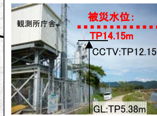
高岡観測所及びCCTV
