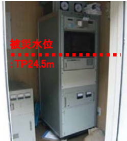
相賀観測所局舎内
