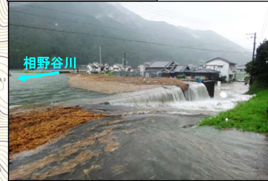
輪中堤からの越水の状況 (高岡避難所より)
