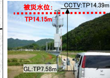
CCTV浸水状況
