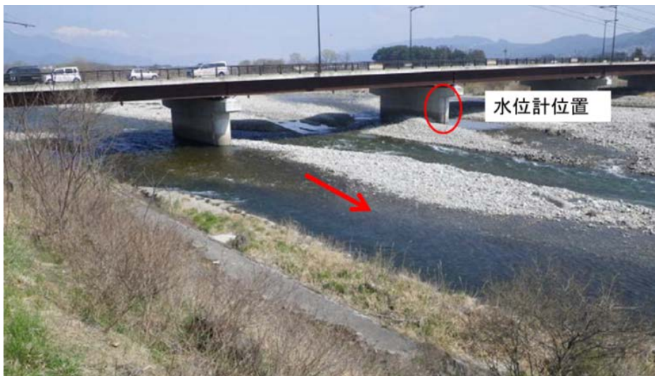
滞筋が変化する河川に設置された水位計
