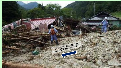
栃木県 日光市 土砂災害の状況
