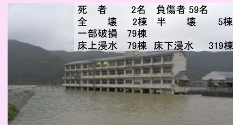
徳島県 阿南市 那賀川水系の浸水状況
