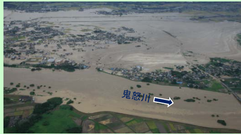
茨城県 常総市 鬼怒川の浸水状況
