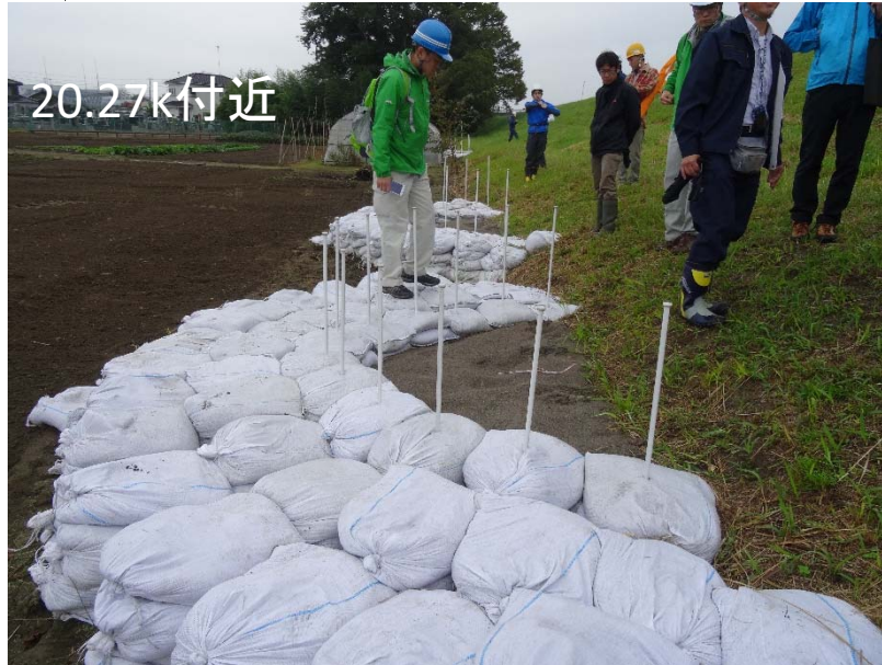
決壊区間付近左岸21.5k, 20.15k~20.27kで、噴砂確認
