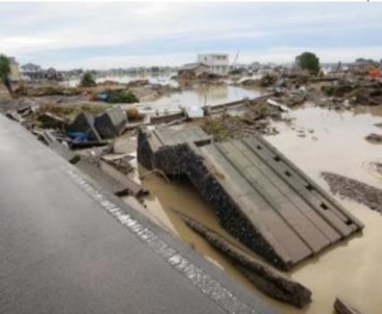
【決壊地点近傍】家屋等の流出状況(撮影日:9/11)
