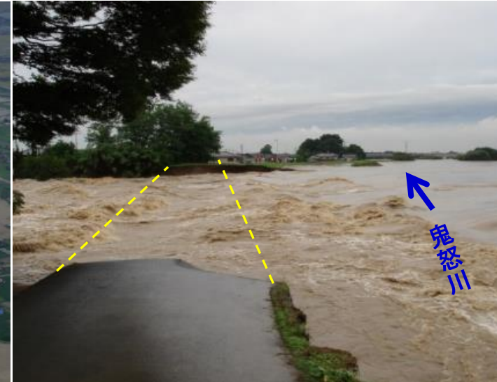
被災状況(拡大写真)
