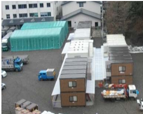
▲仮設ハウス(大槌町仮庁舎)
