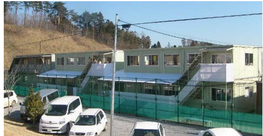
▲仮設ハウス(南三陸町仮庁舎)
