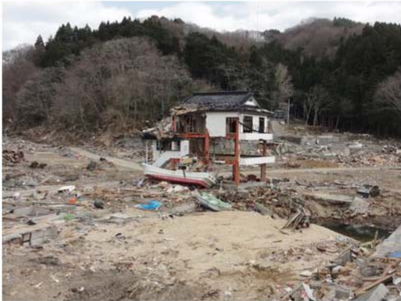
RC建物3階屋根の瓦の浸水線で計測T.P.+12.1m
